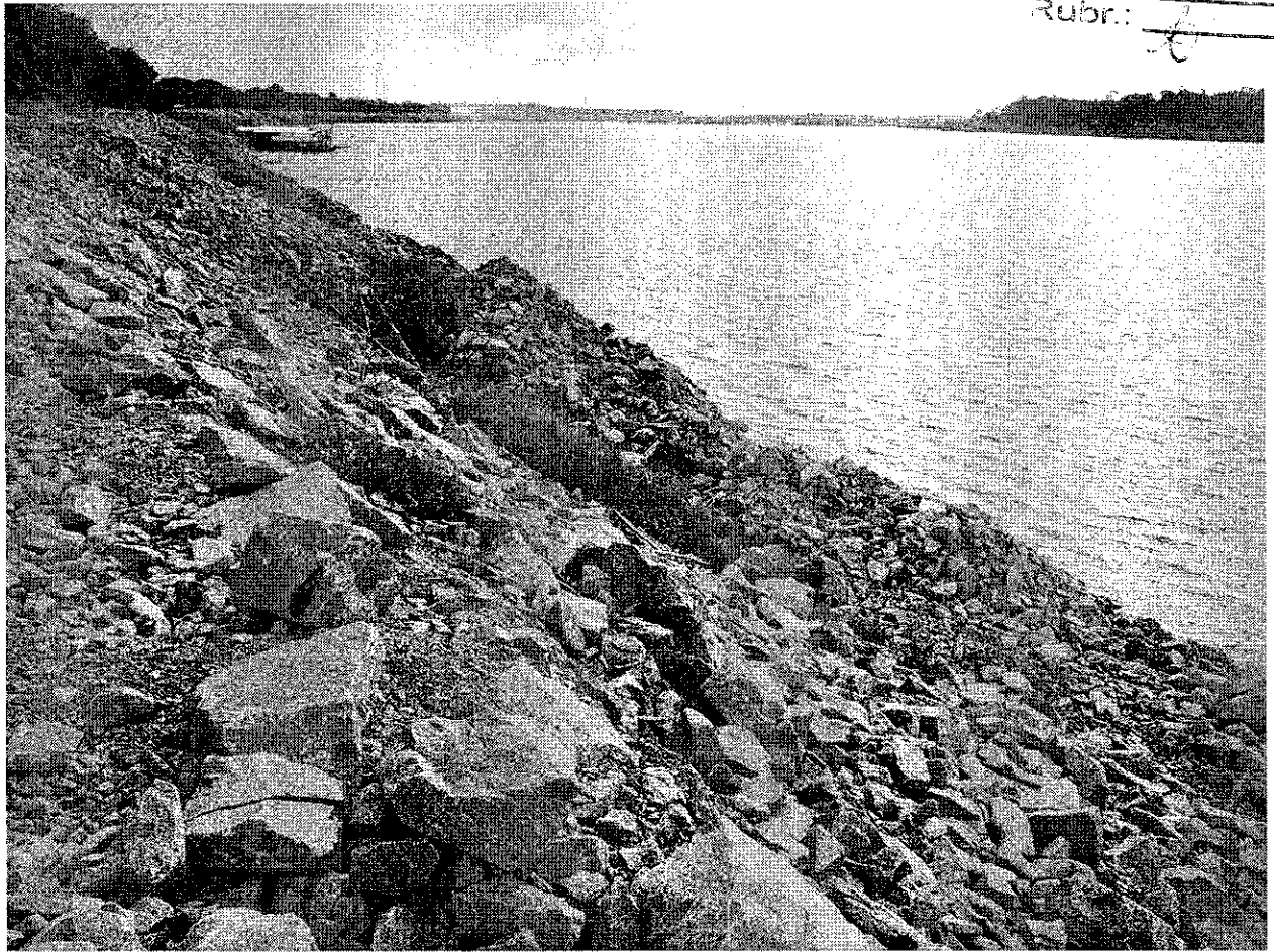
Foto 05 – Registro de talude abatido e ao fundo a berma de contenção sendo construída.
