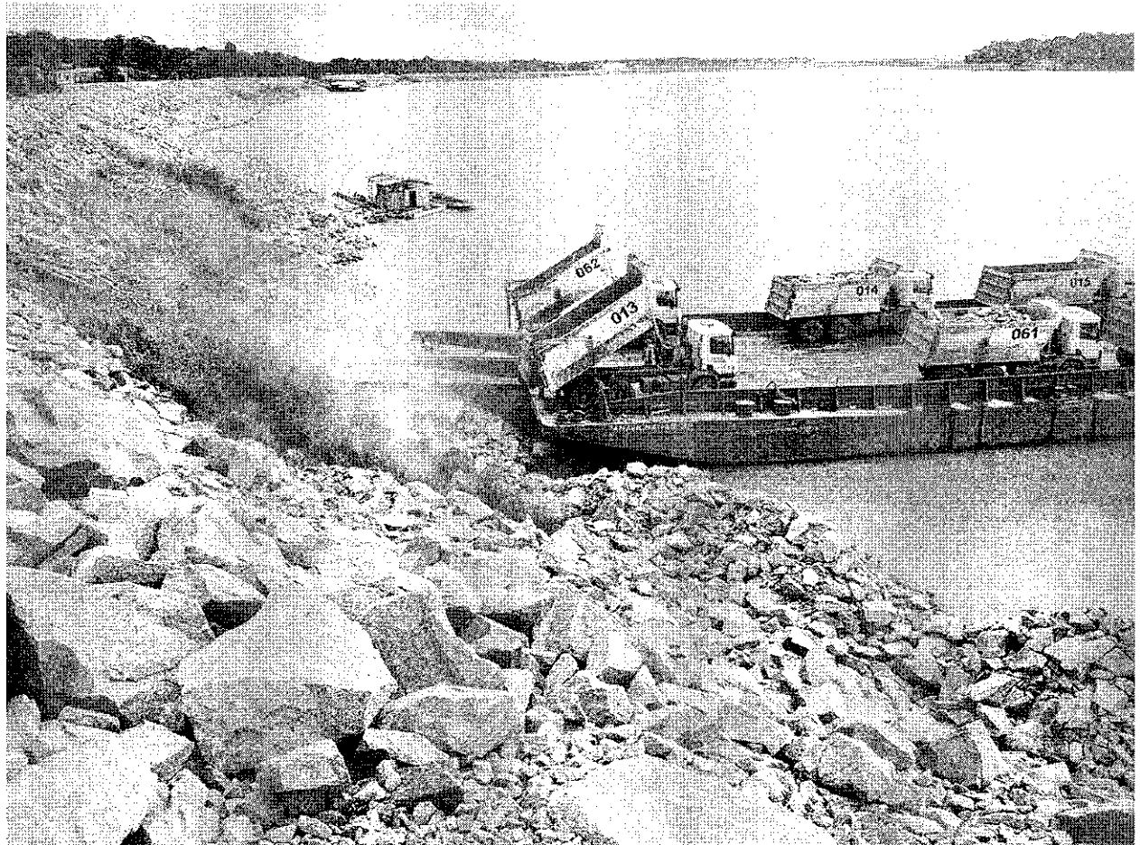
Foto 06 – Balça com caminhões basculantes descarregando rochas para construção da berma.
