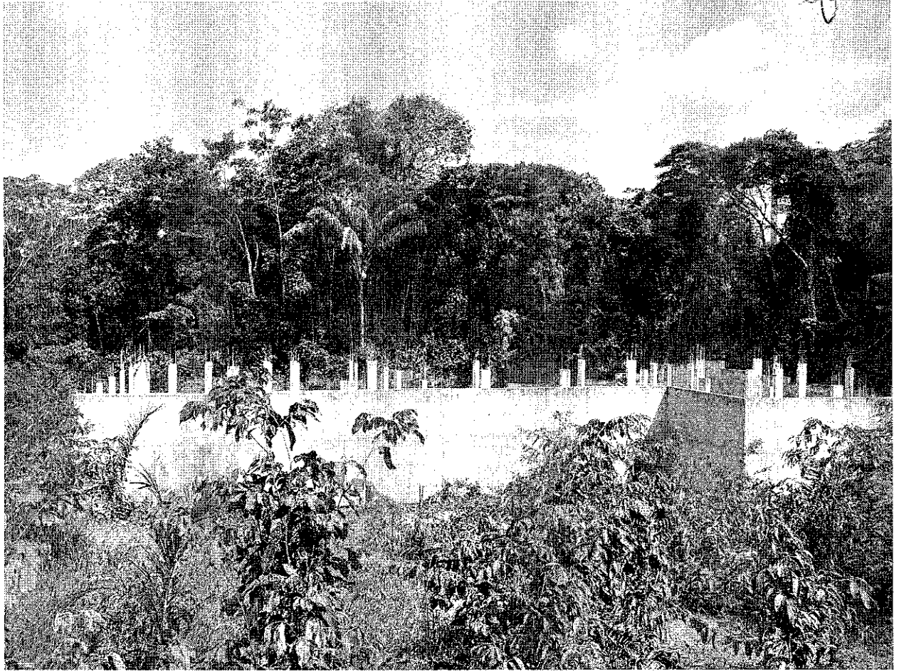
Foto 13 – Fundações Laboratório de Paleontologia
