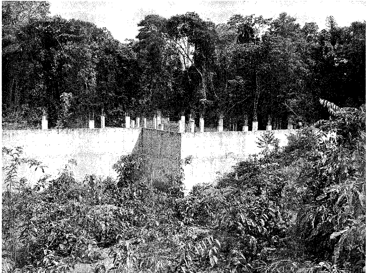
Foto 14 – Fundações Laboratório de Paleontologia
