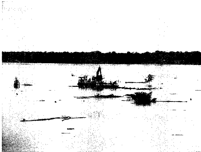
Foto 14 – Utilização da balsa com retroescavadeira
