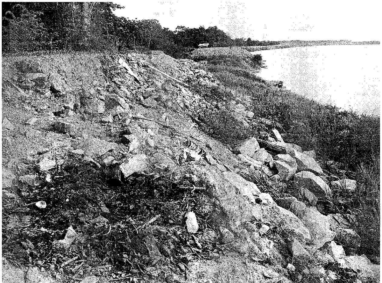
Foto 08 – Registro de talude desbarrancado próximo porto de construção de dragas.
