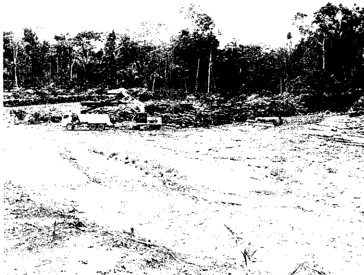
Foto 01 – Carregamento e retirada de madeira em pátio
