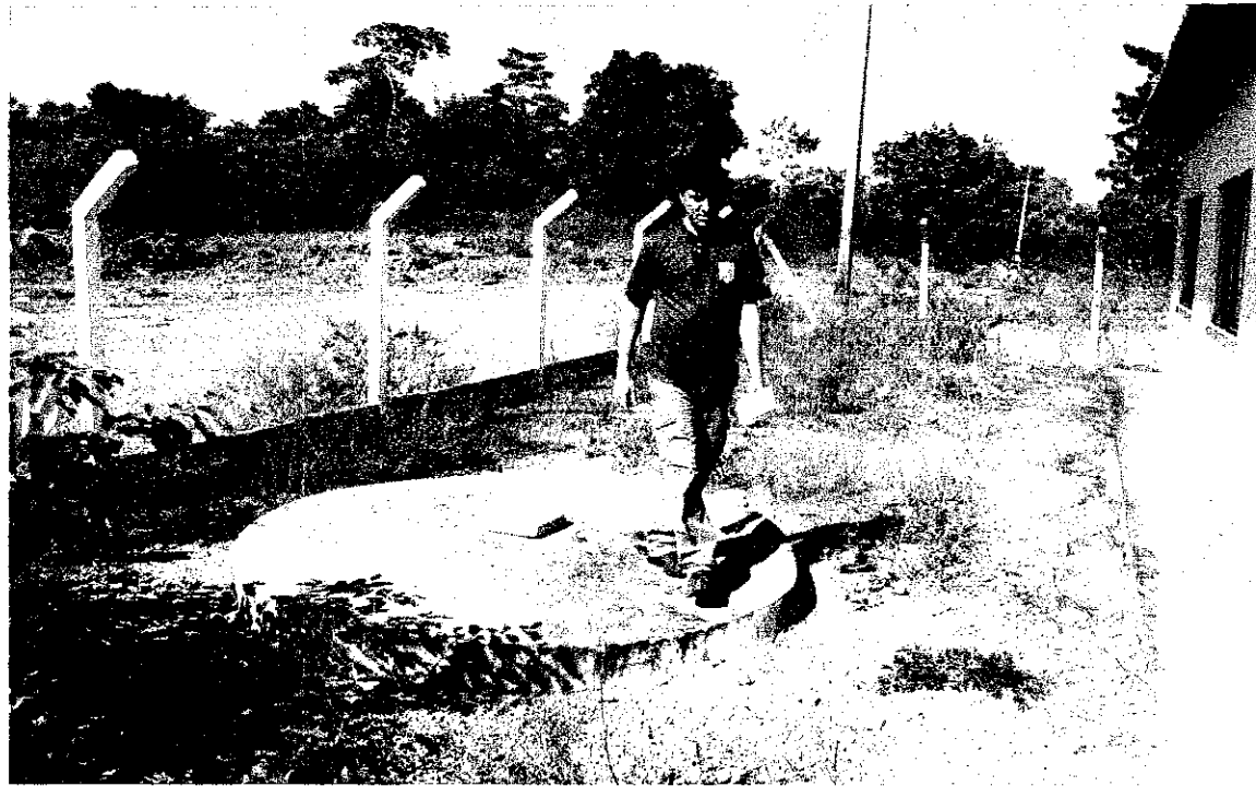
Figura 06 – Fossa séptica reformada da escola Flor do Cupuaçu.
