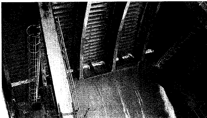
Figura 2 - Peixes aprisionados nas gavetas da comporta radial do VTC (17), no dia 21/04, durante manobra de abertura.
