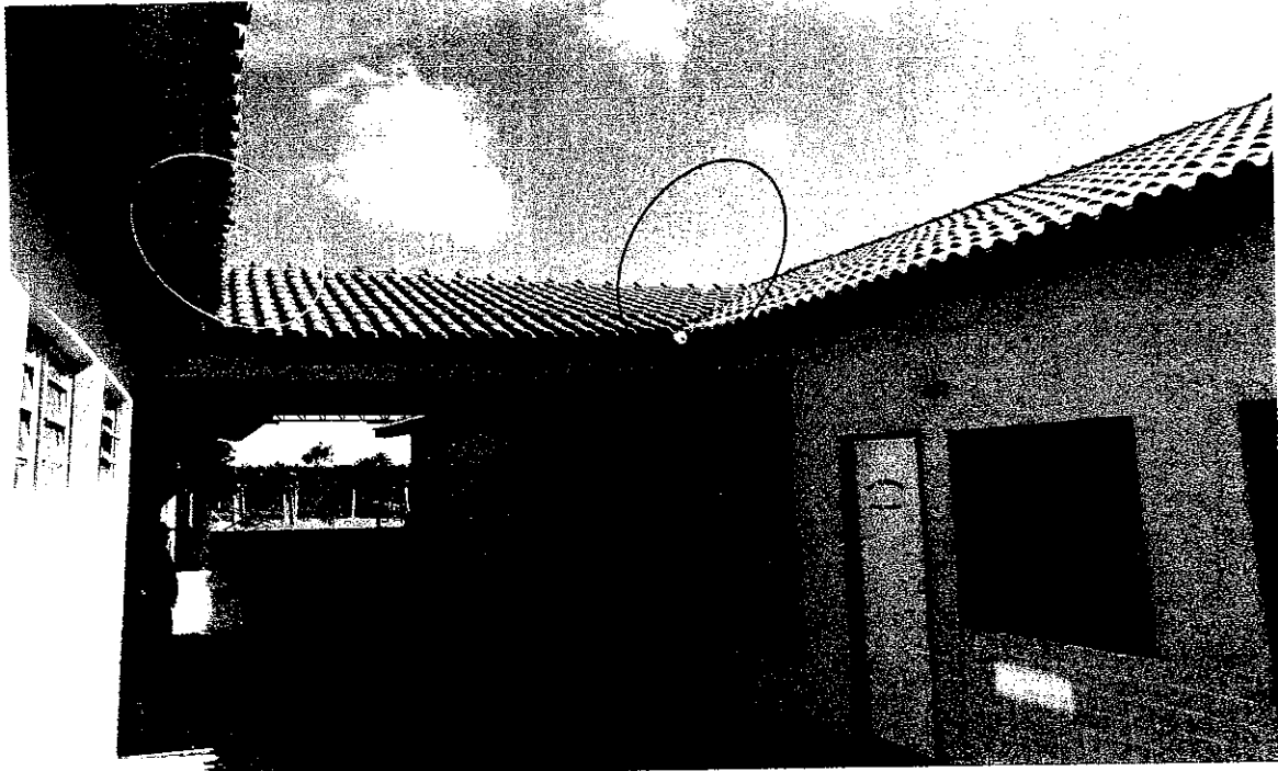
Figura 03 – Escoamento de água direcionado para o interior da escola.
