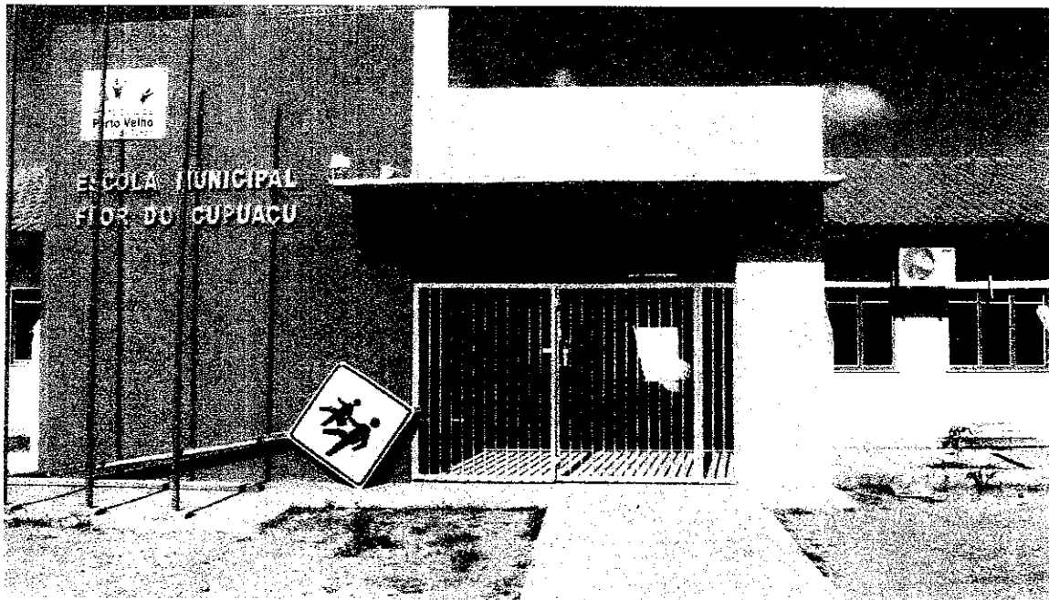
Figura 01 – Escola Municipal “Flor do Cupuaçu”, localizada no reassentamento Santa Rita (Coord. -09 06' 41,97446" -64 10' 03,60279" WGS 84).
