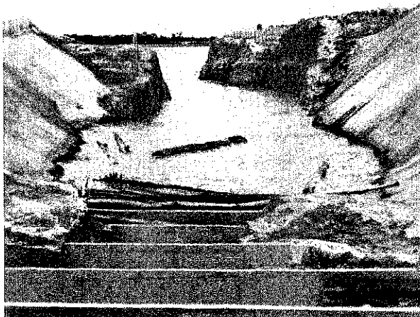
Foto 13: Entrada do canal escavado - início das chicanas.
