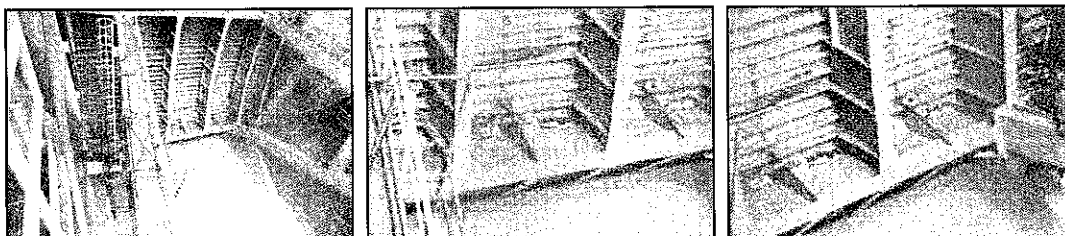
Prancha 1. Vertedouro auxiliar aberto, e detalhe de peixes e madeira presos na bandeja da comporta.
