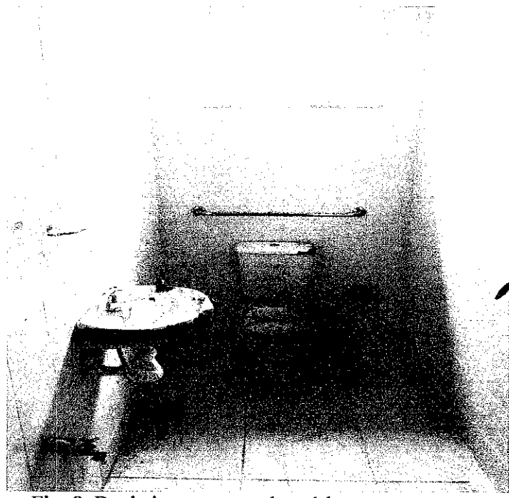
Fig. 8. Banheiro no posto de saúde
