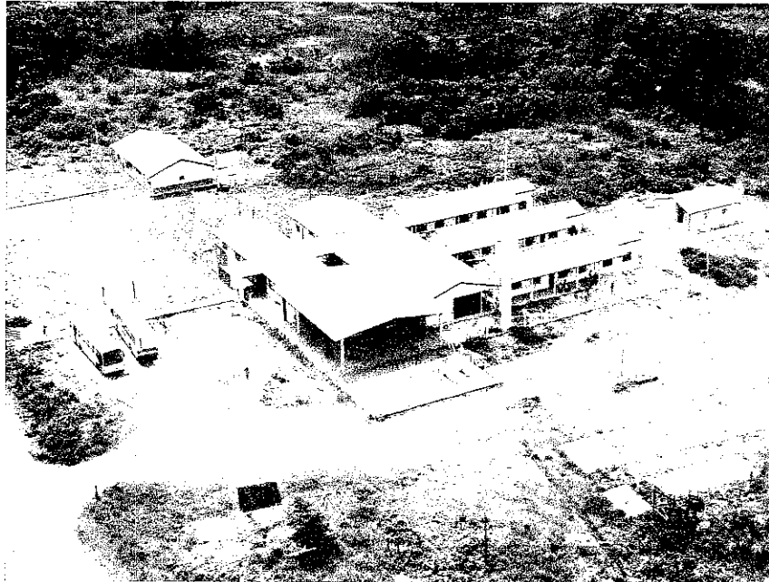
Fig. 33. Escola Reassentamento Santa Rita: necessidade de drenagem.
