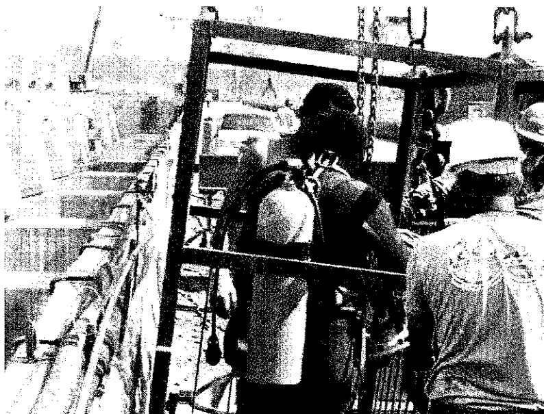
Figura 6 - Mergulhador retorna de verificação dos stop logs no vão 5, antes que seja liberada a ensecagem do recinto.
