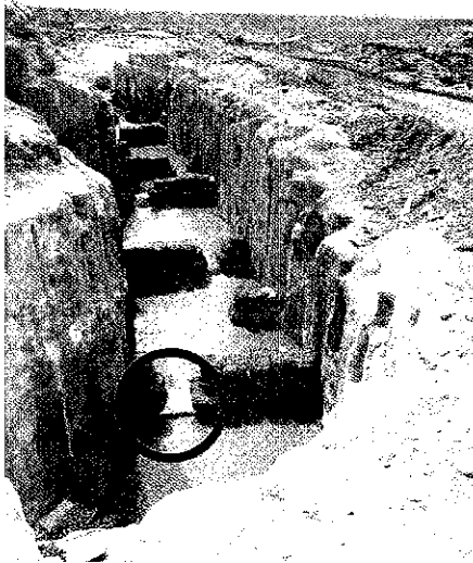
Foto 1: Insuficiência de vazão para o vertimento nos degraus do STP.
