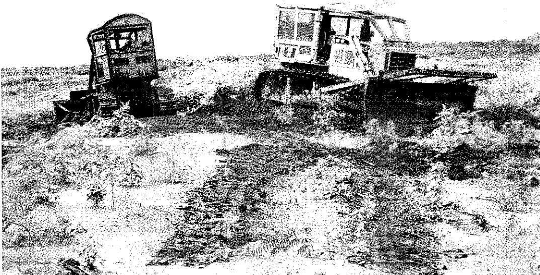
Foto 11 – Tratores de esteira espalhando terra sobre as valas erodidas na Ilha São Patrício.
