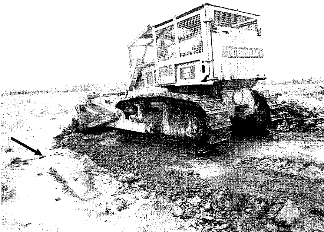
Foto 12 – Tratores de esteira espalhando terra sobre as valas erodidas na Ilha São Patrício.
