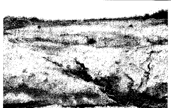
Foto 12: Formação de erosão nos enterrios na região do Alto Jaci Paraná
