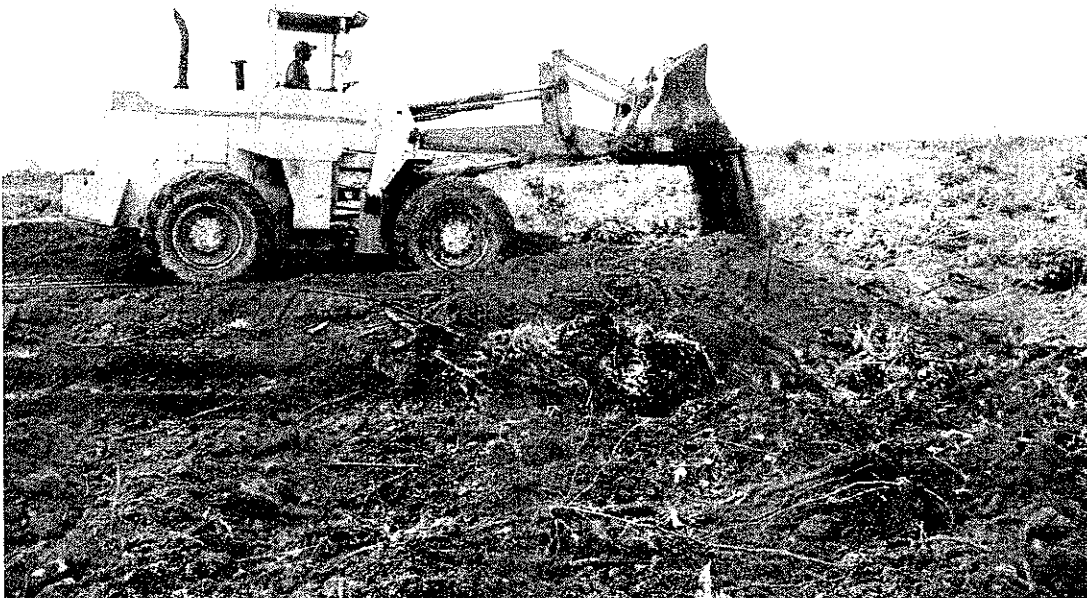
Foto 10 – Pá-carregadeira repondo terra subtraída pela erosão nas valas. Ilha São Patrício.
