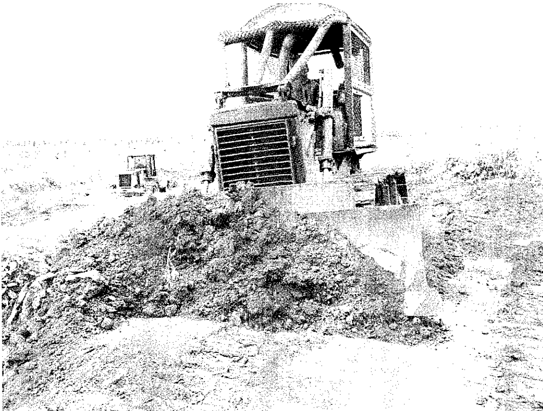
Foto 13 – Tratores de esteira espalhando terra sobre as valas erodidas na Ilha São Patrício.
