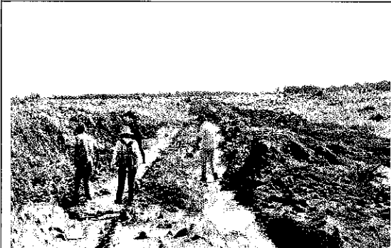
Foto 5: Compactação precária na Ilha do São Patrício.
