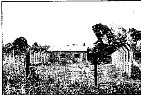
Figura 15 - Casa de Apoio aos Professores em construção.
