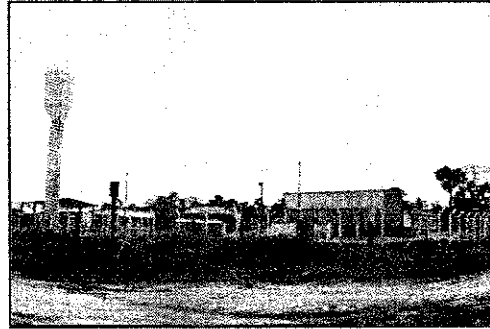
Figura 19- Ponto de Tratamento de Água.
