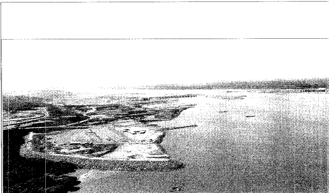
Figura 1 – Registro fotográfico da situação atual do empreendimento.
