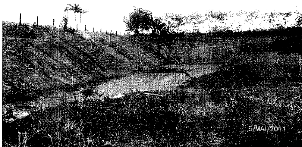
Foto 2 – Vista geral da antiga cava de extração mineral, que ficou localizada no centro da Vila Nova de Teotônio, área do PRAD em apresentação.
