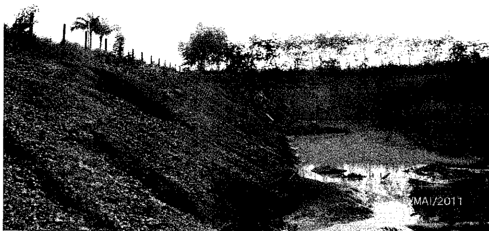
Foto 1 – Vista geral da antiga cava de extração mineral, que ficou localizada no centro da Vila Nova de Teotônio, área do PRAD em apresentação.
