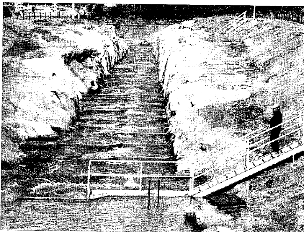
Figura 6. Escada de Peixes da PCH Paranatinga II – Seção retangular com largura de 4,5 m.
