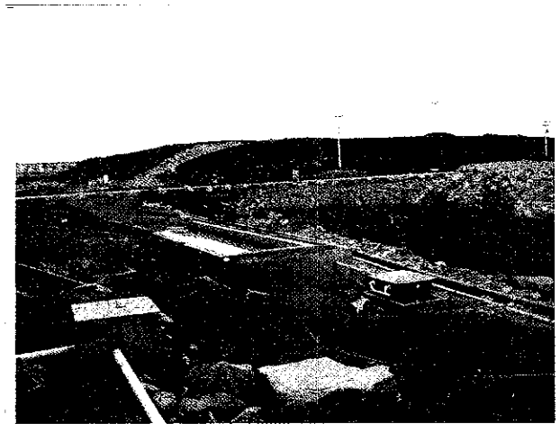
Foto 11 – Sistema de tratamento da água utilizada na lavagem de veículos (margem esquerda).
