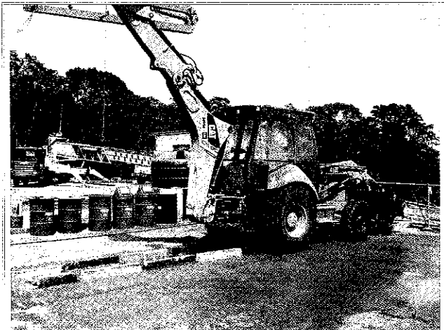
Foto 04 – Área de lavagem de veículo e troca de óleo e graxa (margem direita).
