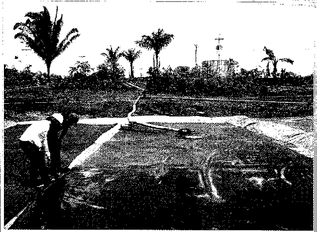
Foto 08 – Estação de Tratamento de Água (margem esquerda).
