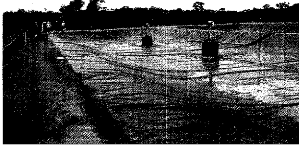
Foto 13 – Células do futuro aterro sanitário para recebimento dos resíduos do canteiro de obras e do Pólo Industrial de Nova Mutum (margem direita).
