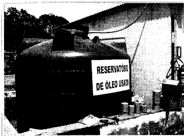
Foto 06 – Reservatório de óleo usado (margem direita).
