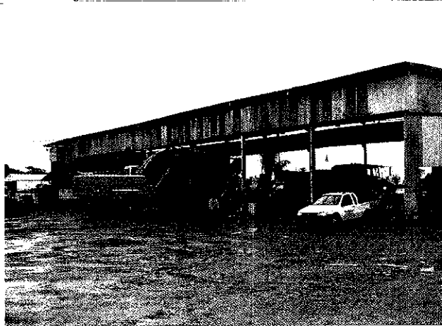
Foto 05 – Galpão onde ocorre a troca de óleo e graxa dos veículos e maquinários (margem direita).
