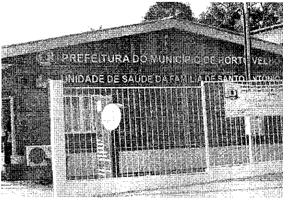
Foto 01 – Implantação de unidade de saúde na vila Santo Antônio
