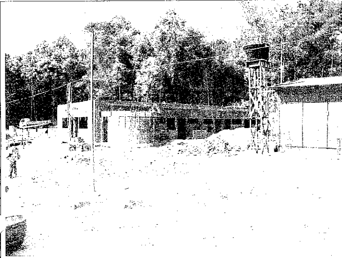
Vista da quarentena em construção já com a lage.
