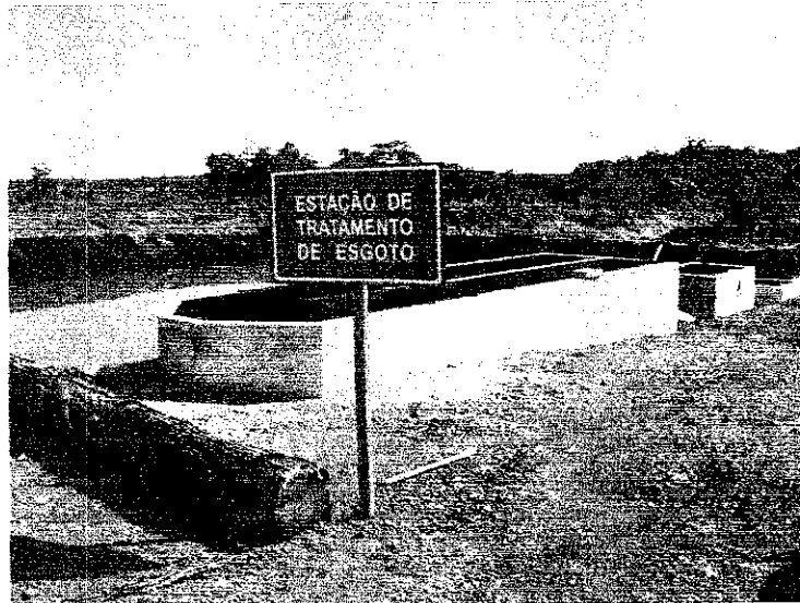
IMAGEM 2. ETE, com a primeira de uma série de lagoas. Atentar ao sistema de retenção de sólidos, constituído de 6 módulos de separação.
