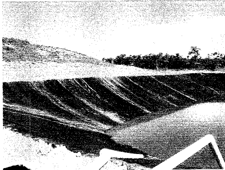
IMAGEM 6. ETE, com a primeira de uma série de lagoas. Notar a declividade do terreno adjacente a primeira lagoa. A equipe técnica do IBAMA recomendou medidas preventivas de adequação de todo o conjunto a fim de aumentar o nível de segurança.
