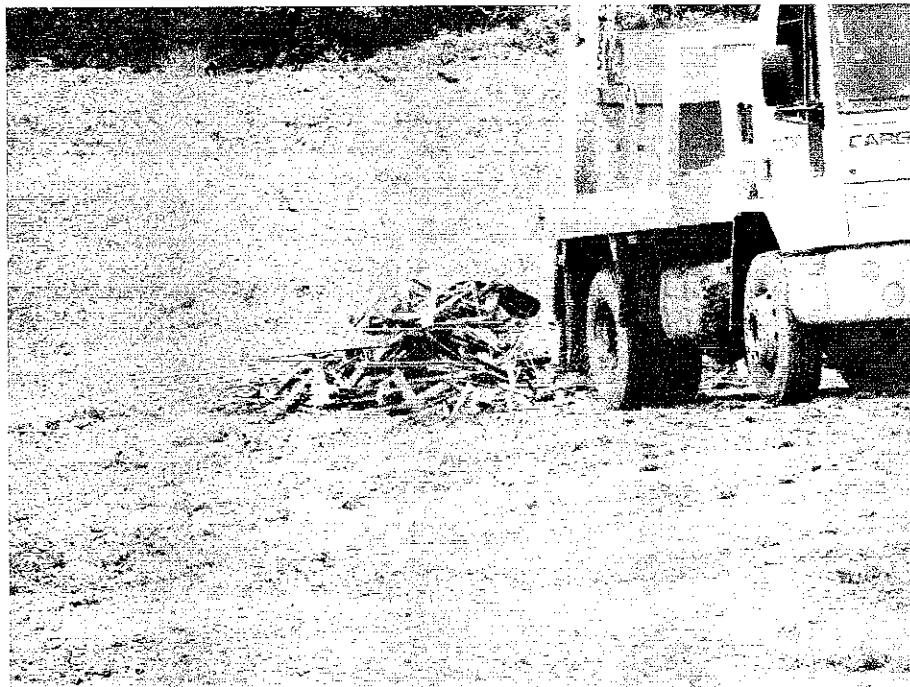
Foto 10 – Depósito de resíduo de construção na margem direita
