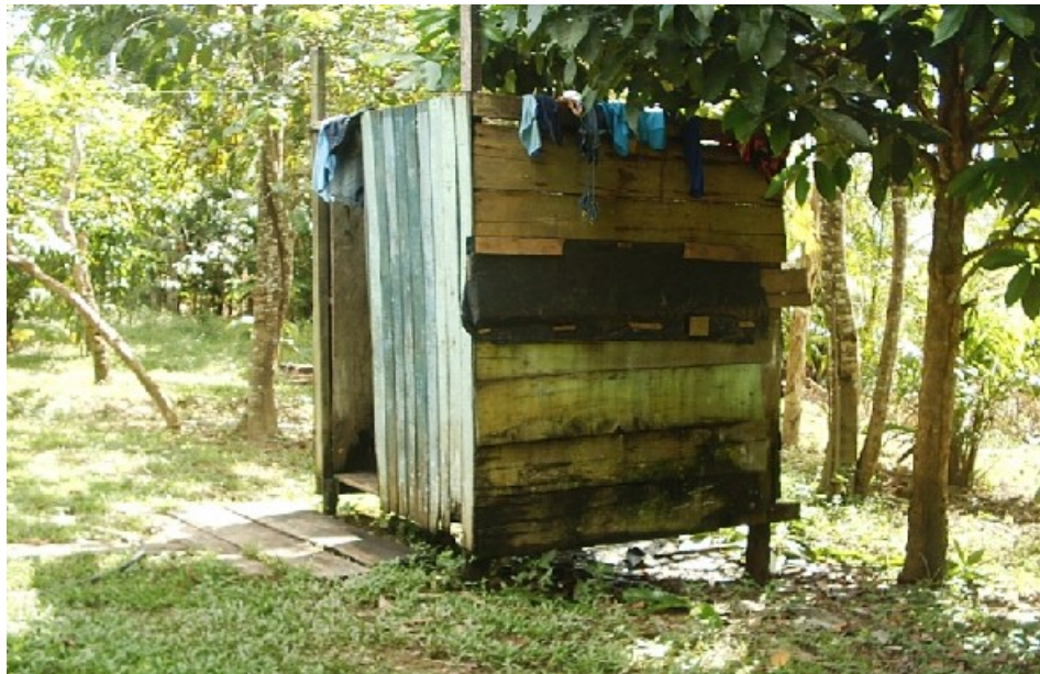
Foto 24: Foto representativa de unidade sanitária com fechamento em painéis de madeira, enquadrável na tabela “O”.
