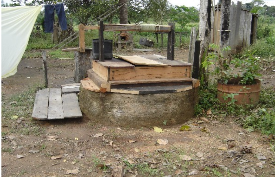
Foto 29: Foto representativa de cisterna com mureta de proteção, enquadrável na tabela “V”.
