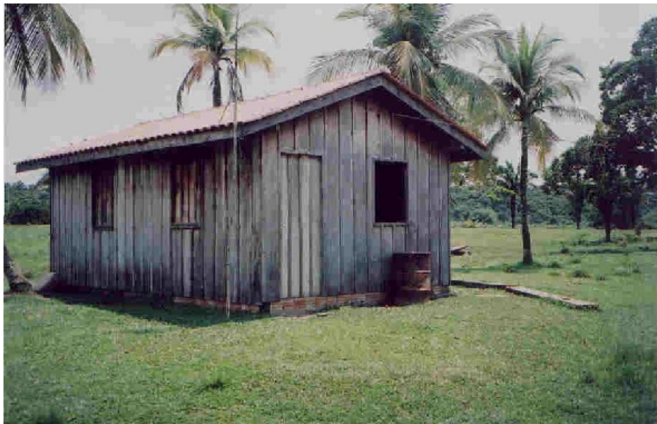
Foto 08: Foto representativa de residência em painéis de madeira, com mata-junta. Construída sobre alicerce de tijolo furado, considerada de padrão popular e enquadrável na tabela “E”.
