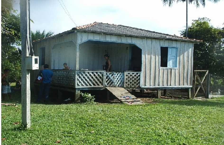
Foto 07: Foto representativa de residência em painéis de madeira, com mata-junta. Construída sobre palafita, considerada de padrão popular e enquadrável na tabela “H”.
