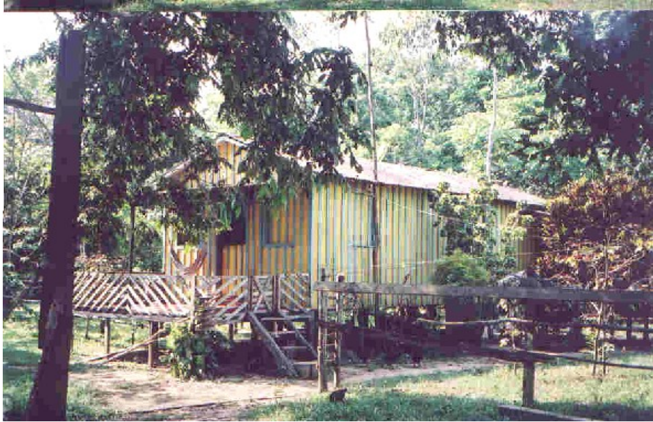
Foto 05: Foto representativa de residência em painéis de madeira, com mata-junta. Construída sobre palafita, considerada de padrão popular e enquadrável na tabela “H”.
