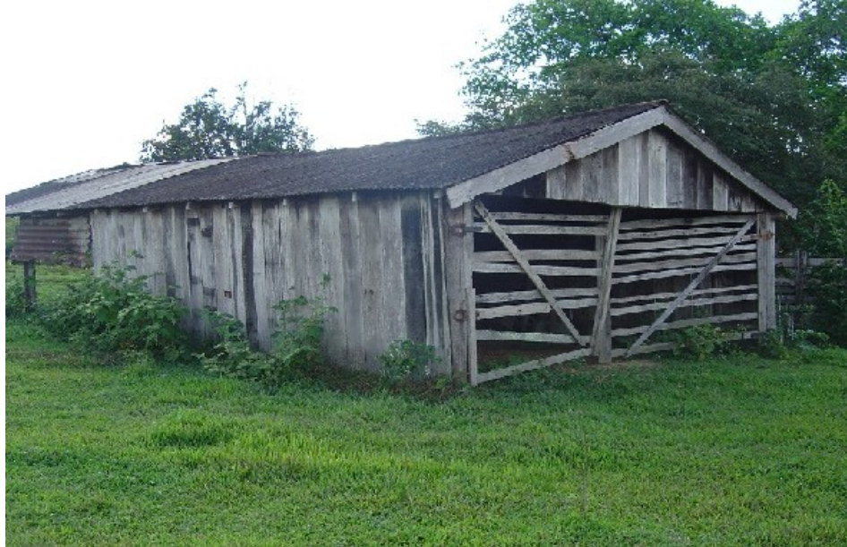
Foto 23: Foto representativa de paiol/depósito com fechamento em painéis de madeira, enquadrável na tabela “N” ou “P”.
