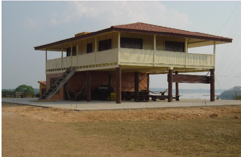
Foto 01: Foto representativa de residência em painéis pré-fabricados de madeira, tipo “macho e Fêmea”. Construída sobre palafita, considerada de padrão médio e enquadrável na tabela “G”.
