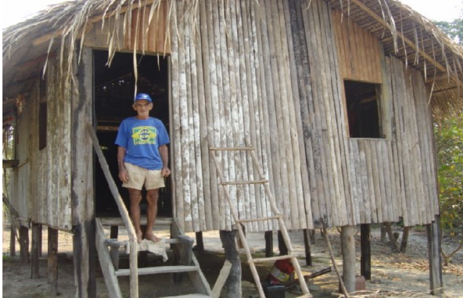
Foto 33 Foto representativa de residência em painéis de madeira, tipo pau-a-piq, sobre palafita. Enquadrável na tabela “J”.
