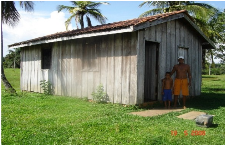
Foto 10: Foto representativa de residência em painéis de madeira, com mata-junta. Construída sobre alicerce de tijolo furado, considerada de padrão popular e enquadrável na tabela “E”.
