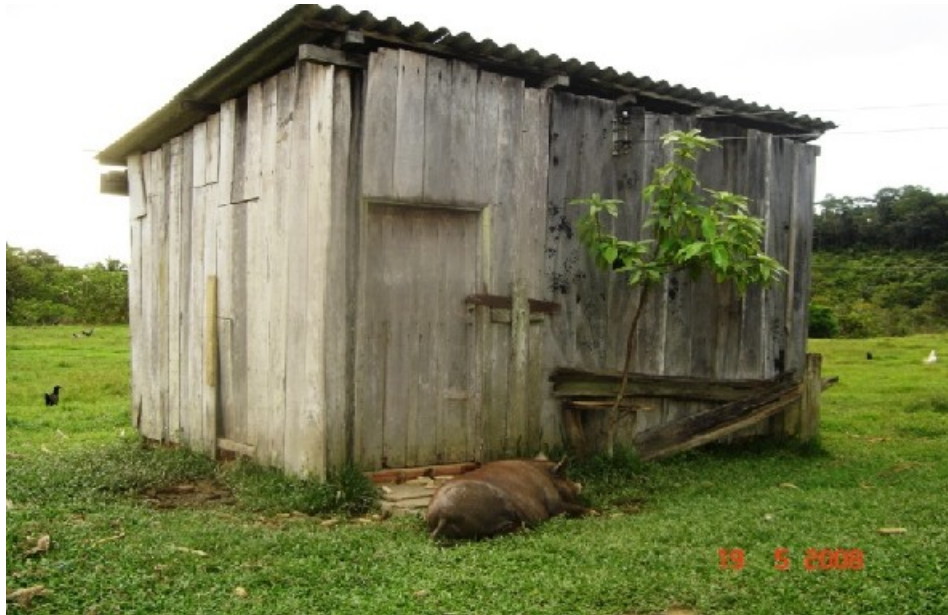
Foto 21: Foto representativa de pocilga com fechamento em painéis de madeira, enquadável na tabela “R”.
