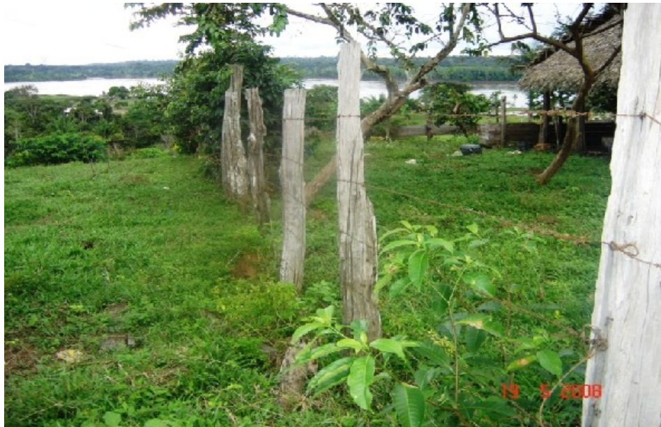
Foto 20: Foto representativa de cerca de arame farpado, com 5 fios em lascas de madeira de lei, enquadrável na tabela “Q”.
