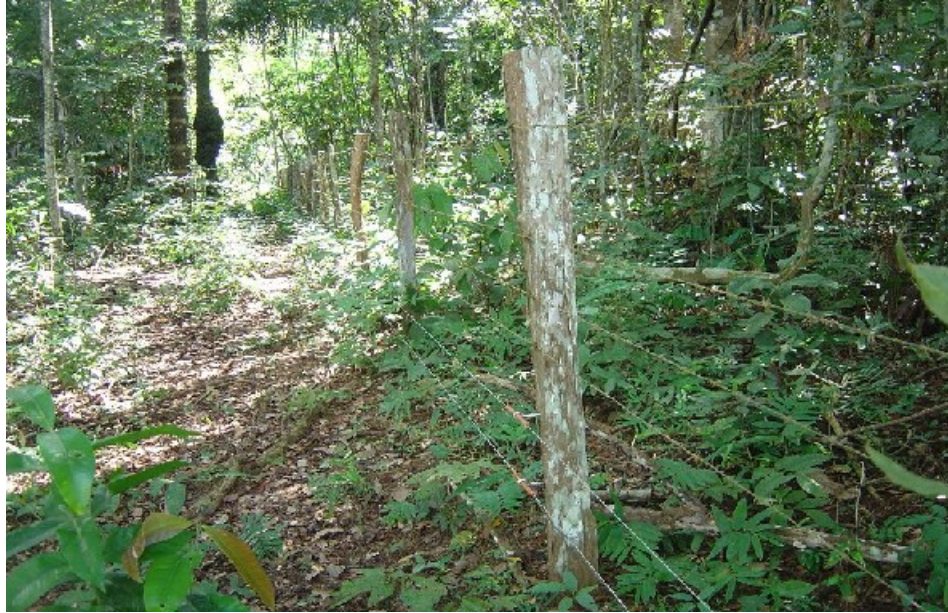
Foto 19: Foto representativa de cerca de arame liso, com 6 fios em estacas roliças de madeira de lei, enquadrável na tabela “Q”.
