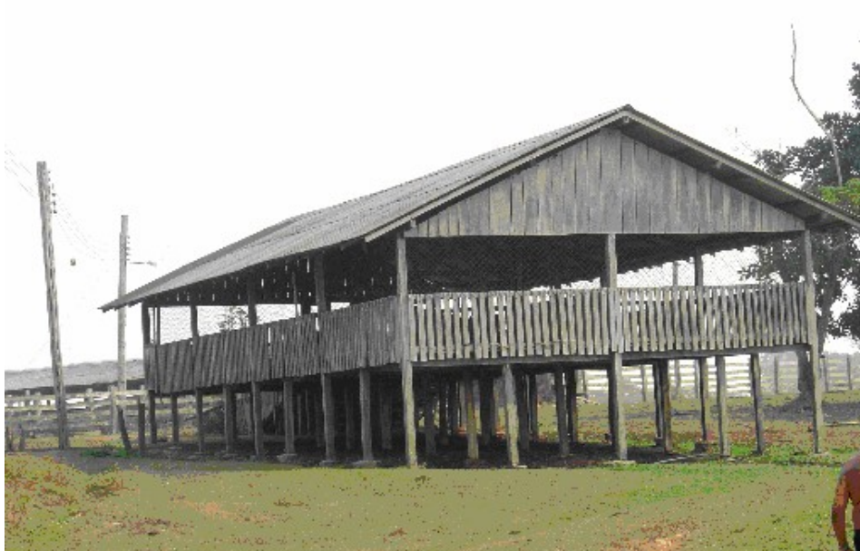
Foto 12 Foto representativa de aprisco com cobertura em telhas de fibrocimento, enquadrável na tabela “X”.
