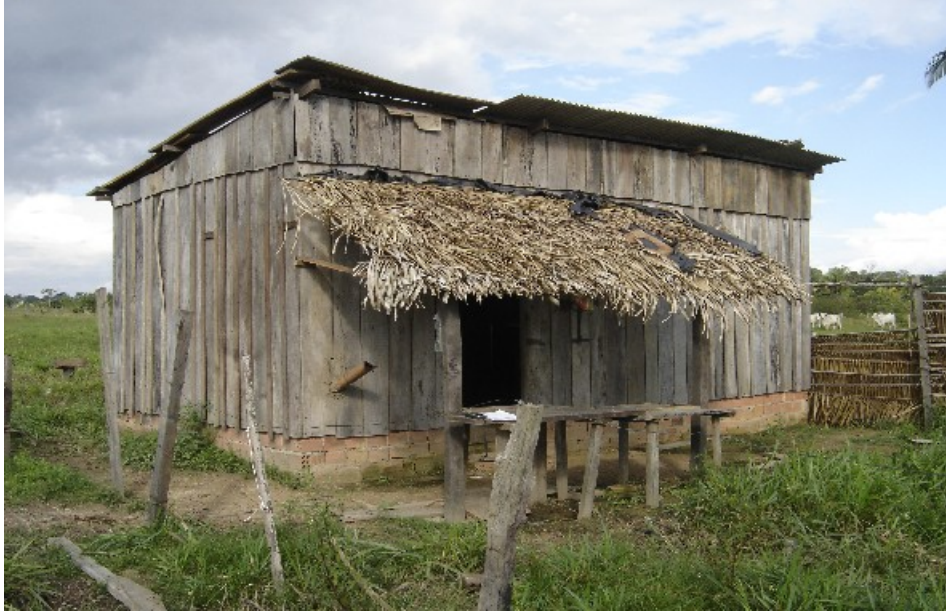
Foto 09: Foto representativa de residência em painéis de madeira, com mata-junta. Construída sobre alicerce de tijolo furado, considerada de padrão popular e enquadrável na tabela “E”.
