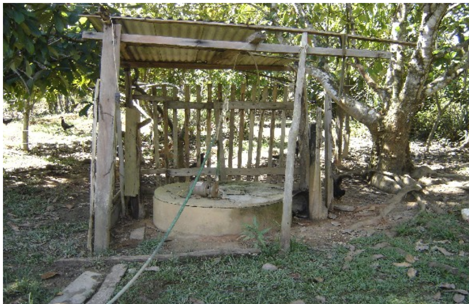
Foto 30: Foto representativa de cisterna com mureta de proteção, enquadrável na tabela “V”.
