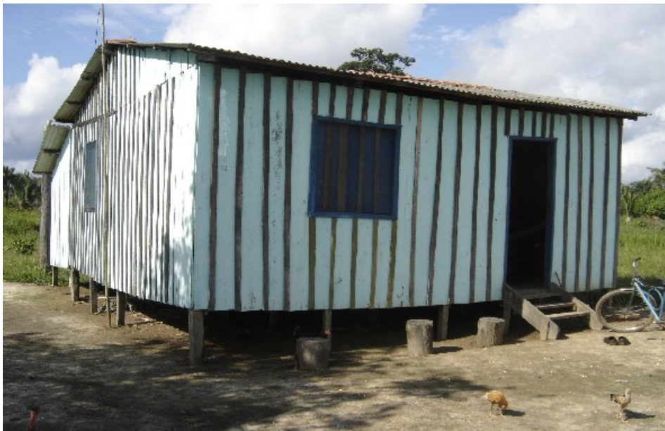
Foto 06: Foto representativa de residência em painéis de madeira, com mata-junta. Construída sobre palafita, considerada de padrão popular e enquadrável na tabela “H”.
