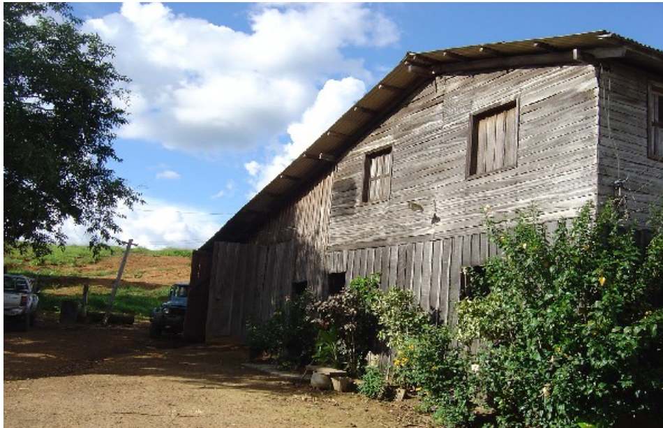
Foto 32 Foto representativa de residência em painéis de madeira, com dois pavimentos. Enquadrável na tabela “C”.
