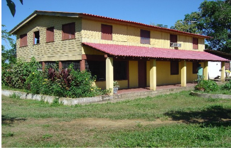
Foto 31 Foto representativa de residência em painéis de madeira, com dois pavimentos. Enquadrável na tabela “C”.
