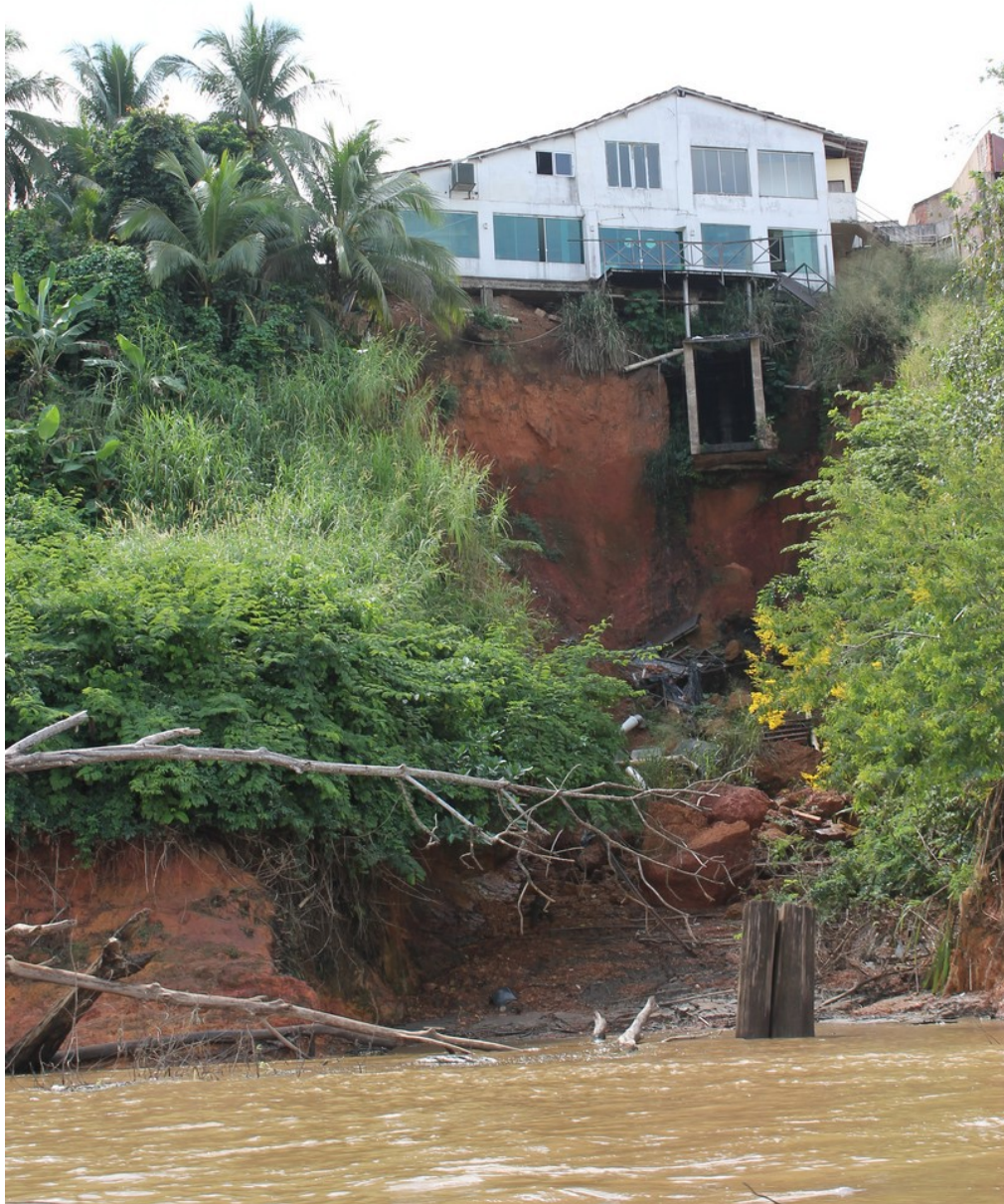
Foto 5 – Café Madeira e a queda do talude.
