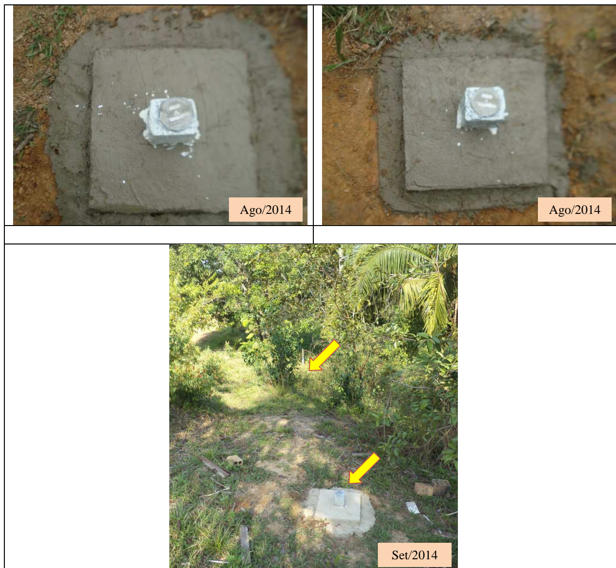
Figura 3.87 Marcos de Referência Implantados no Local de Monitoramento 18
