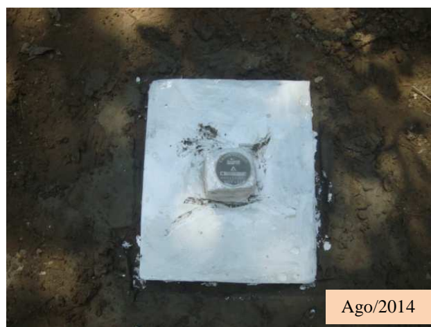
Figura 3.64 Instalação dos Novos Marcos de Referência no Local de Monitoramento 14
