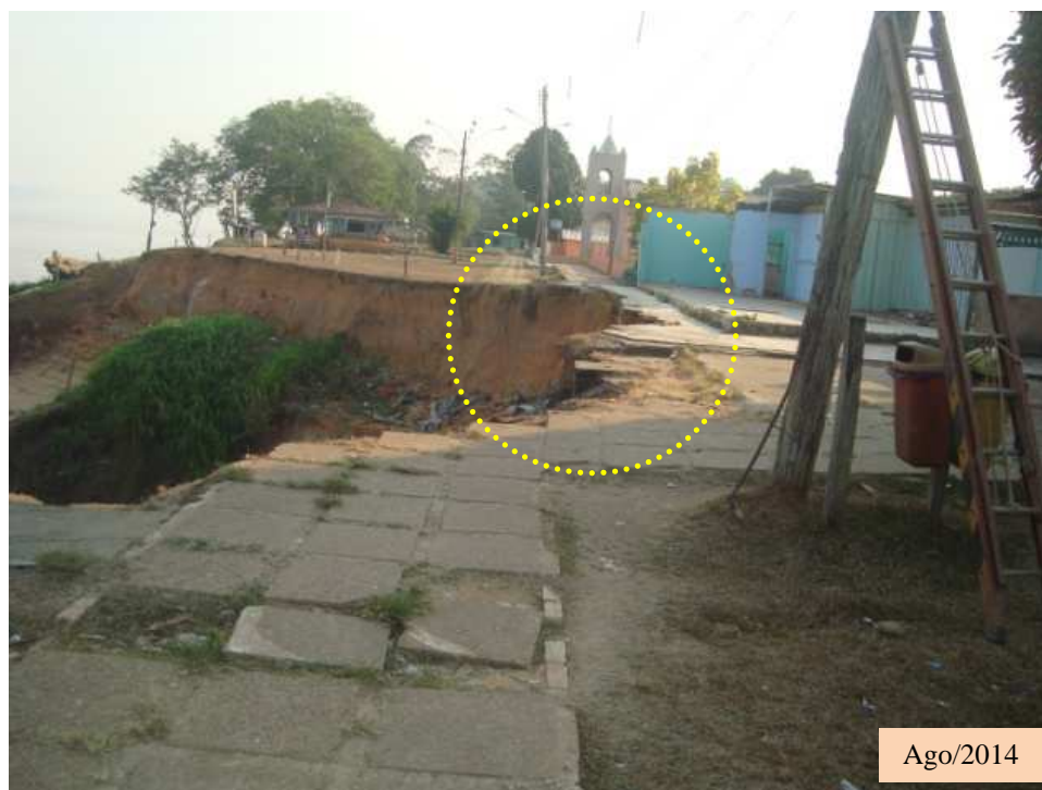
Figura 3.60 (continuação) Detalhe do Processo Erosivo no LM-13 em Fevereiro/2011, Agosto/2011, Julho/2012, Julho/2013 e Agosto/2014
