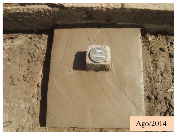
Figura 3.34 Instalação dos Marcos de Referência no Local de Monitoramento 8
