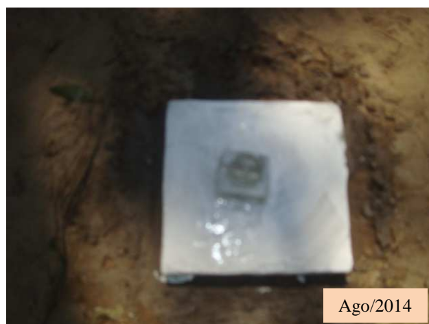
Figura 3.64 Instalação dos Novos Marcos de Referência no Local de Monitoramento 14
