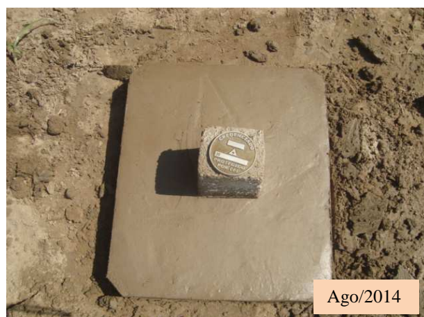
Figura 3.34 Instalação dos Marcos de Referência no Local de Monitoramento 8
