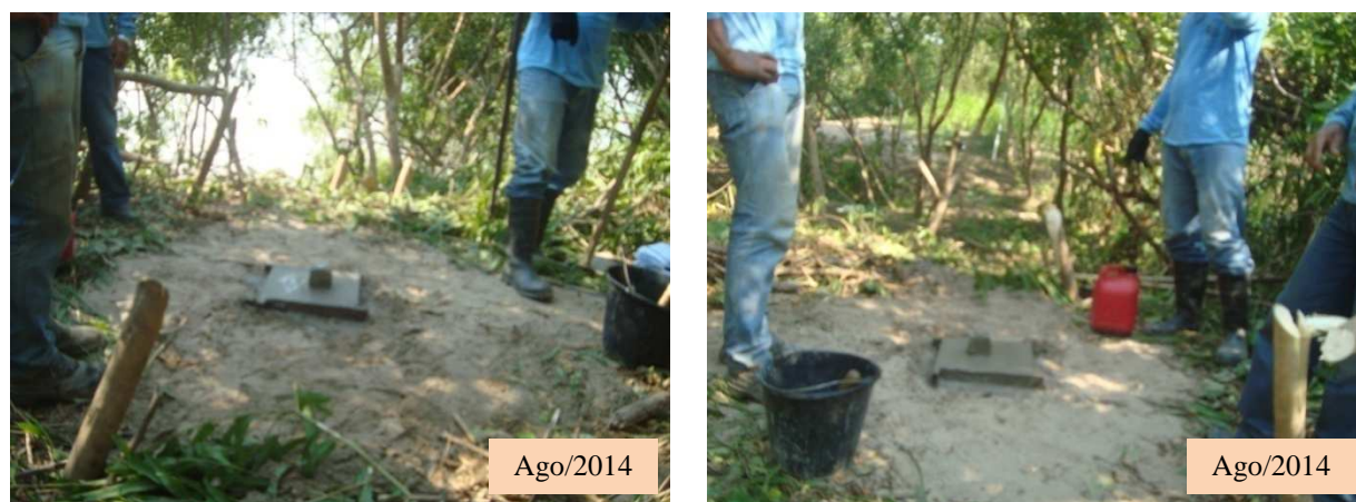
Figura 3.54 Instalação de Novos Marcos de Referência no Local de Monitoramento 12 durante o Levantamento de Agosto/2014
