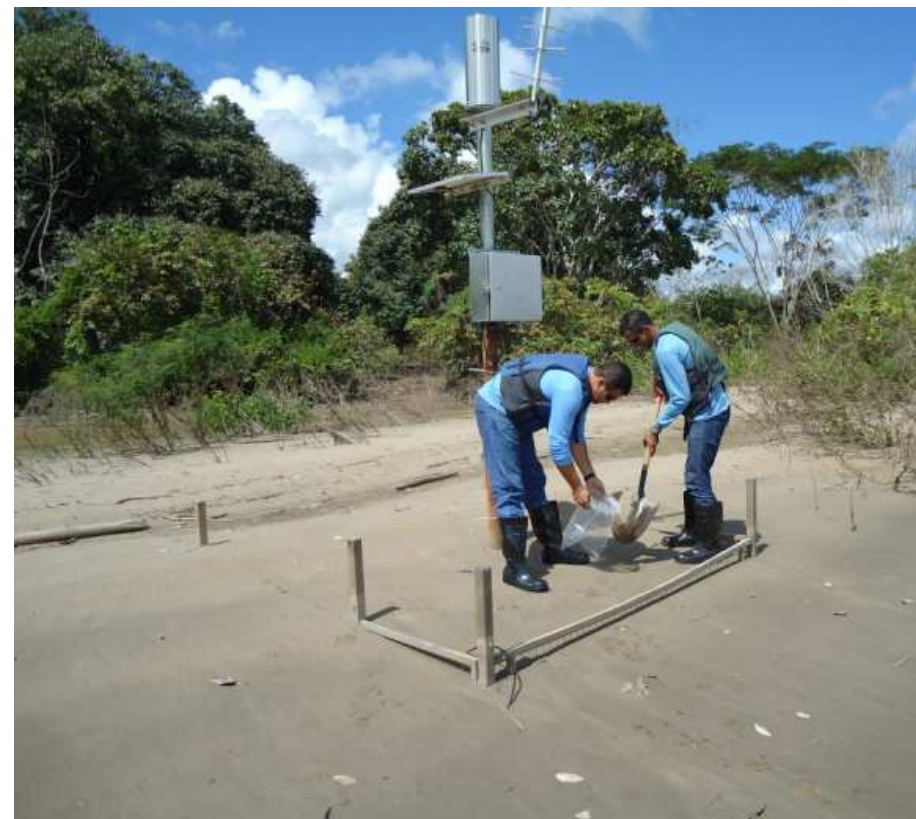
Figura 2.4 Vista Geral da Estação Telemétrica Jusante Caldeirão do Inferno Antes e Após a Passagem da Cheia/2014 (verificar que o cercado da estação ficou totalmente soterrado)
