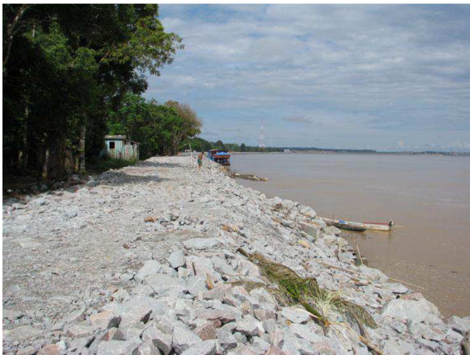
Figura 3.5 Enrocamento da Margem Direita do Rio Madeira desde a Usina até o Cai n'Água
