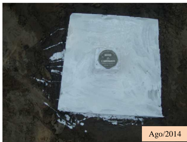
Figura 3.77 Instalação de Novos Marcos de Referência no Local de Monitoramento 16
