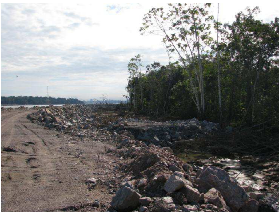
Figura 3.6 Vista do Enrocamento nas Imedições do LM-1
