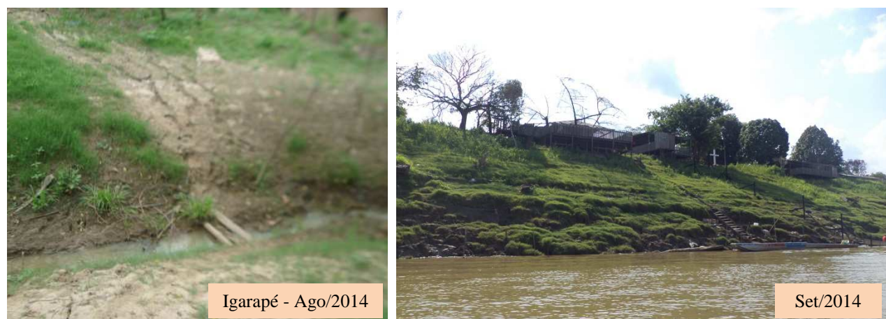
Figura 3.88 Vista do Local de Monitoramento 18
