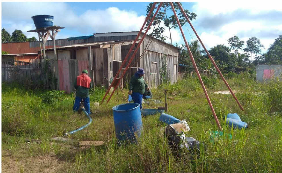
Figura 18 – Preparação de equipamento para realização de sondagem no distrito de Jacy-Paraná.
