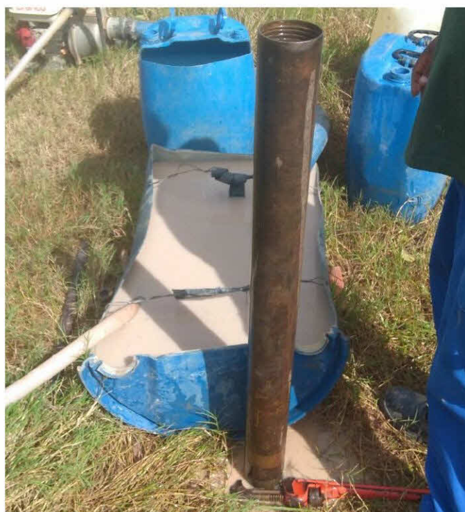
Figura 19 – Preparação do material para realização de ensaio de permeabilidade durante sondagem no distrito de Jacy-Paraná.
