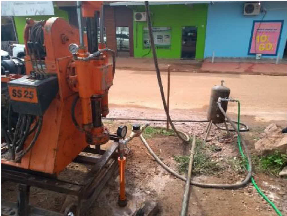
Figura 40 – Equipamento de sondagem rotativa posicionado no distrito de Jacy-Paraná.
