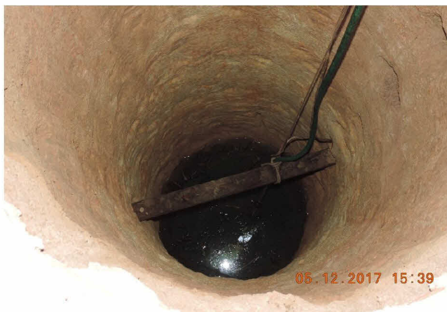
Figura 12 – Aspectos de paredes de poço cacimba não revestido cadastrado no distrito de Jacy-Paraná.
