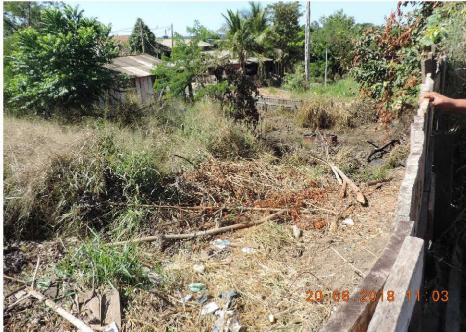
Figura 27 – Exemplo de problemas relacionados à locação do imóvel em aterro próximo a uma drenagem.
