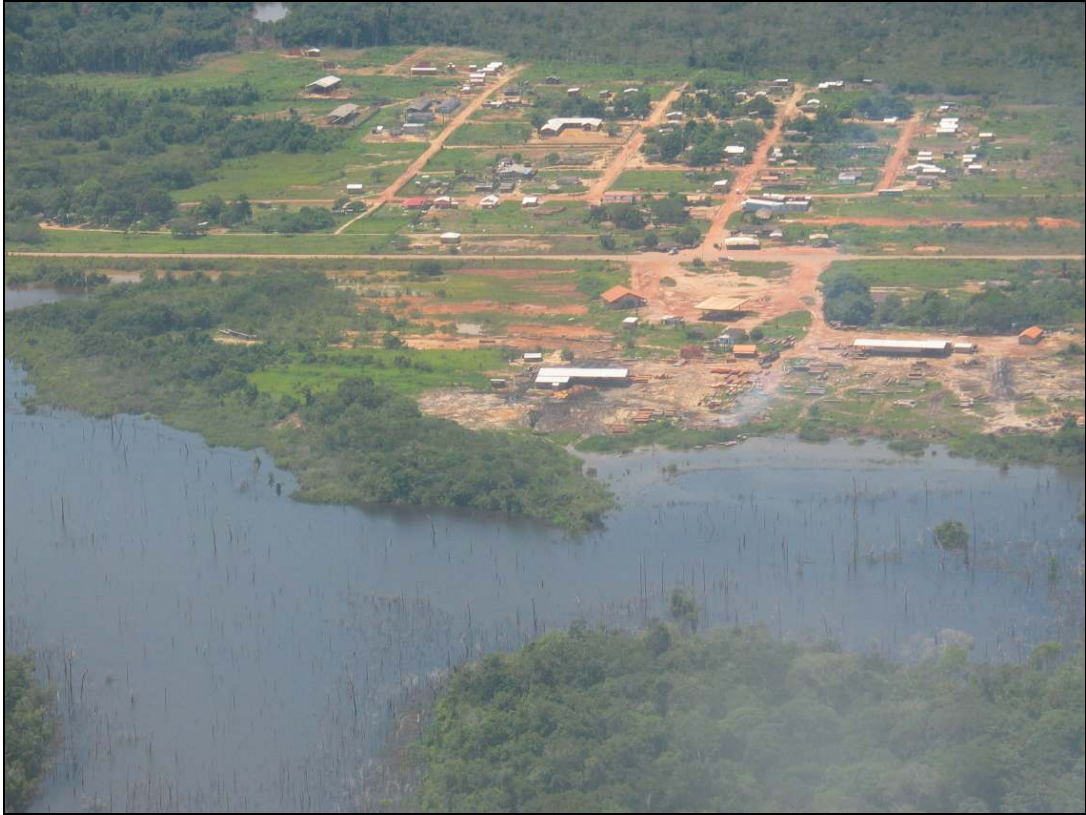
Foto 18 – Presença de árvores mortas no interior do reservatório artificial
