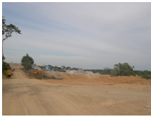
Área de britagem
