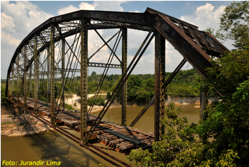
FIGURA 11 - Vista lateral da ponte da EFMM sobre o rio Jaci-Paraná
