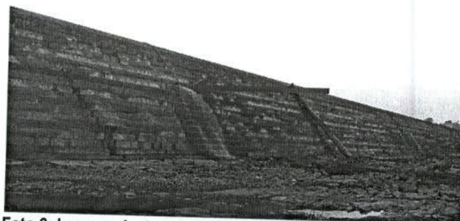
Foto 6: Imagem destacada da Foto 1 para o lançamento da água do reservatório na área em questão.
