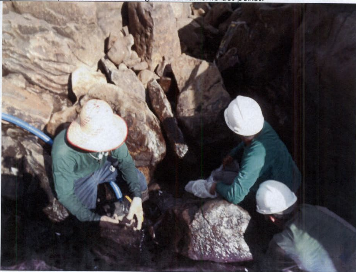
Figura 6. Processo de esvaziamento da água nas poças e fendas através da utilização de bomba de sucção.
