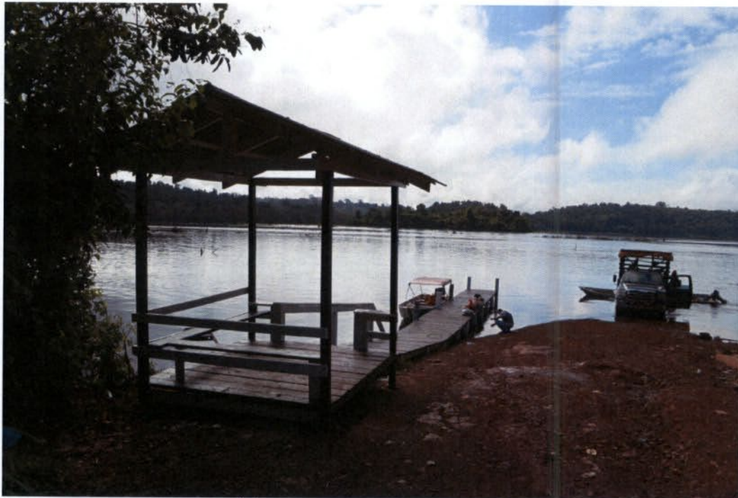
Trapiche de Atracação de Porto Sabão
