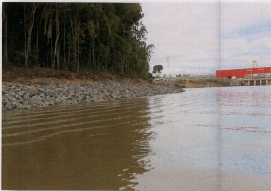
Figura 3- Vista geral da proteção do talude
