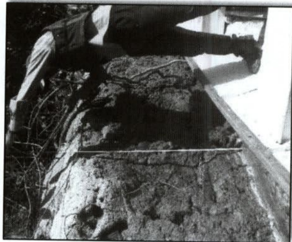
PA 04 – Monitoramento e Controle de Processos Erosivos
