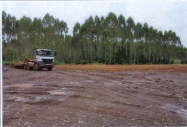
Foto 07: Local onde havia o canteiro administrativo.
