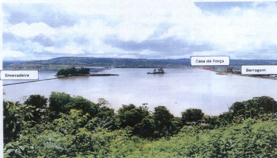
Figura 3 – Fotografia da área alagada entre a ensecadeira e o barramento.
