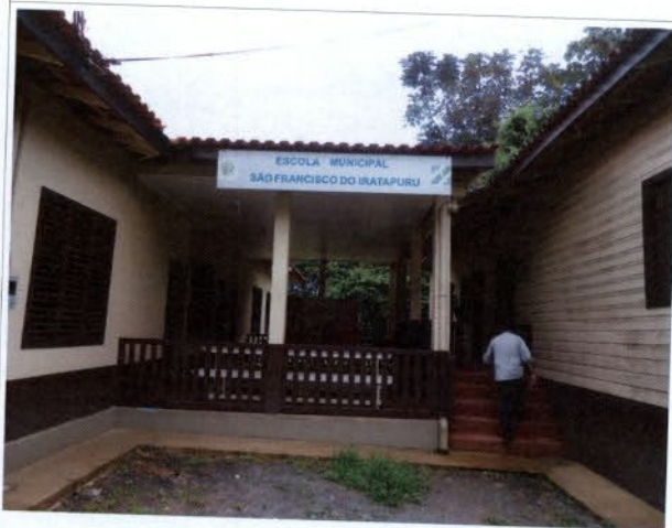
Foto 27: Reforma e Ampliação da Escola da Vila Iratapuru.
