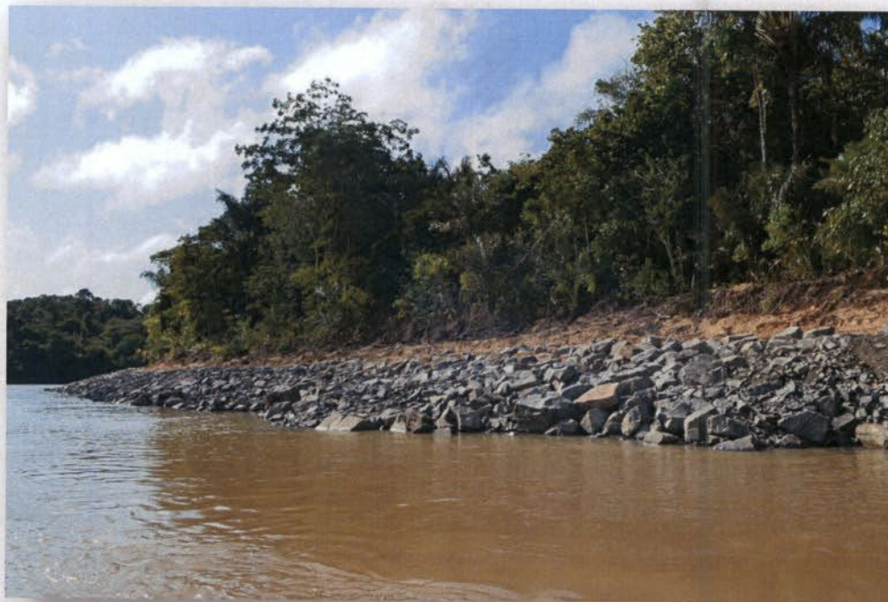
Figura 1 – Vista geral da proteção do talude
