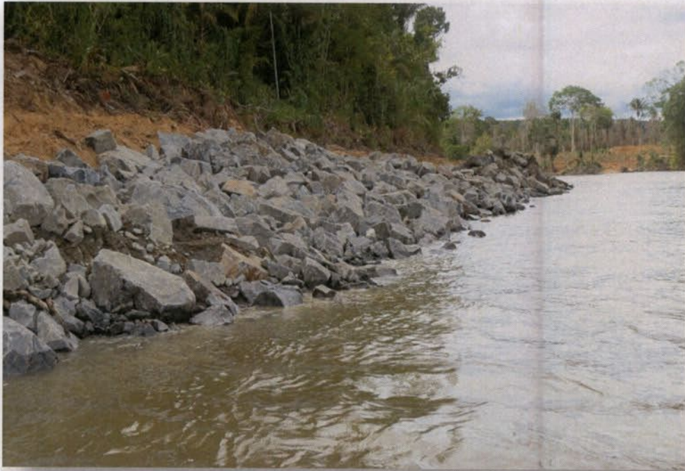
Figura 5- Vista geral da proteção do talude
