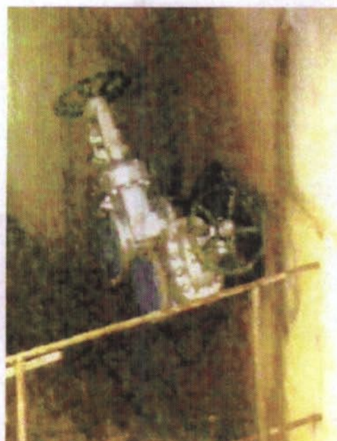
Fig. 1 – Válvulas da comporta da vazão sanitária e da tubulação de serviço/incêndio
