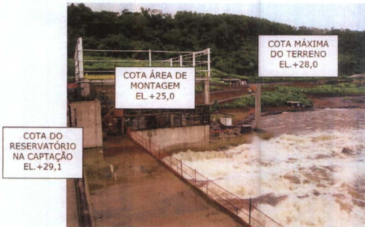
Fig. 3 – Cotas da Casa de Força Complementar
