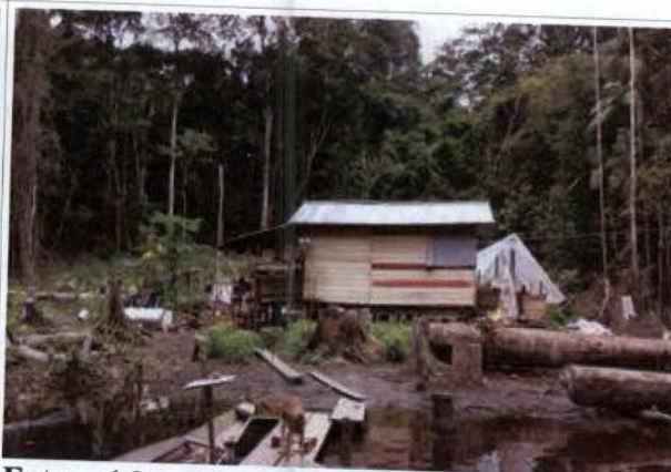
Foto 16: Casa construída na APP do reservatório, em área vizinha ao açcaizal próximo à residência da Sra. Gracinete da Silva (D. Júlia). Observa-se árvores derrubadas.
