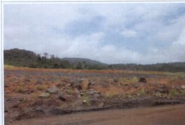
Foto 11: Canteiro localizado logo abaixo do barramento, já desmobilizado.
