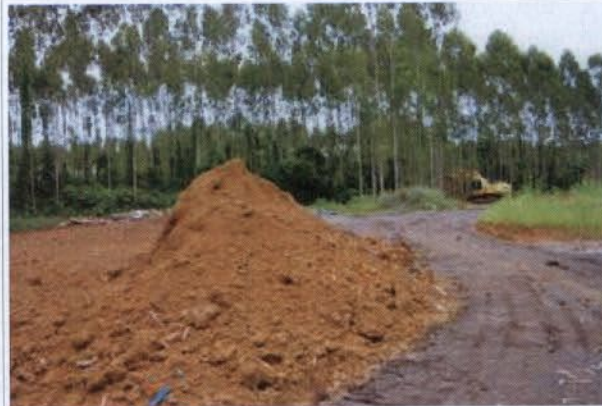
Foto 09: Local onde havia o canteiro administrativo. Observa-se ainda a presença de resíduos das construções existentes.
