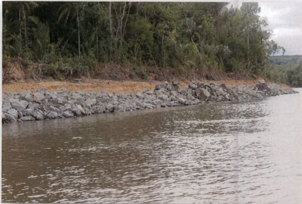
Figura 5- Vista geral da proteção do talude
