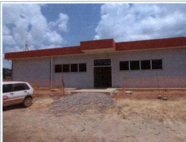
Foto 01: Casa de comando na Área de Apoio da Usina.
