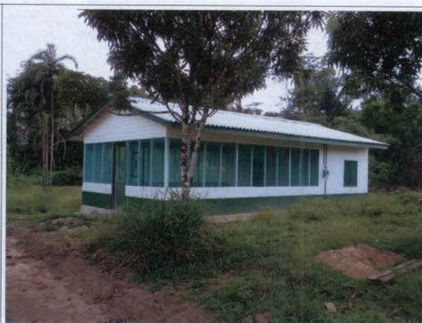
Foto 30: Imóvel reconstruído da Comaru.
