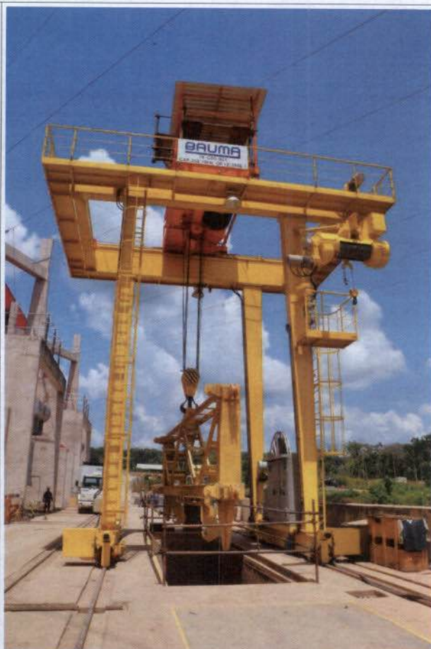
Foto 10: Estrutura tipo “guindaste” utilizada para transportar os peixes resgatados do interior do tubo de sucção para o trecho do rio à jusante da barragem.
