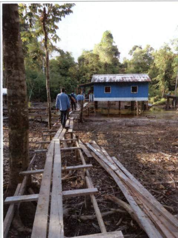
Foto 36: Construção na APP da UHE Santo Antônio do Jari.
