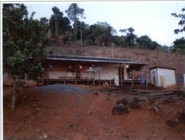
Foto 35: Moradia reconstruída da Sr a Gracinete.
