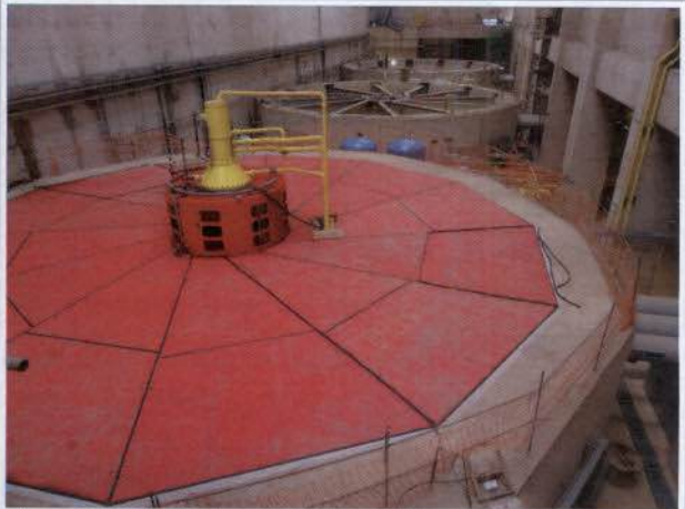
Foto 19: Instalação das turbinas de geração de energia.
