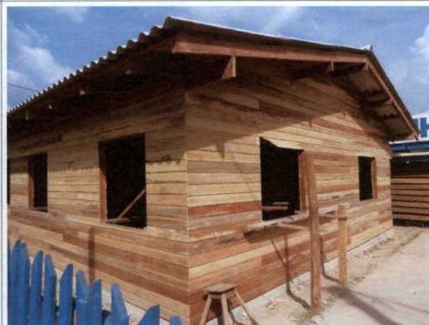
Foto 26: Salas de aula em construção em Laranjal do Jari/AP.
