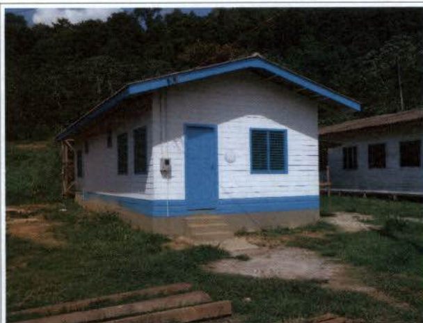
Foto 23: Posto de Saúde reformado.
