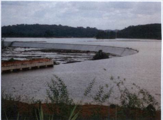
Foto 20: Vertedouro de soleira livre da UHE Santo Antônio do Jari.
