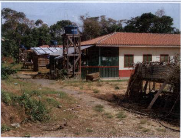
Foto 33: Ampliações das residências construídas pela EDP.
