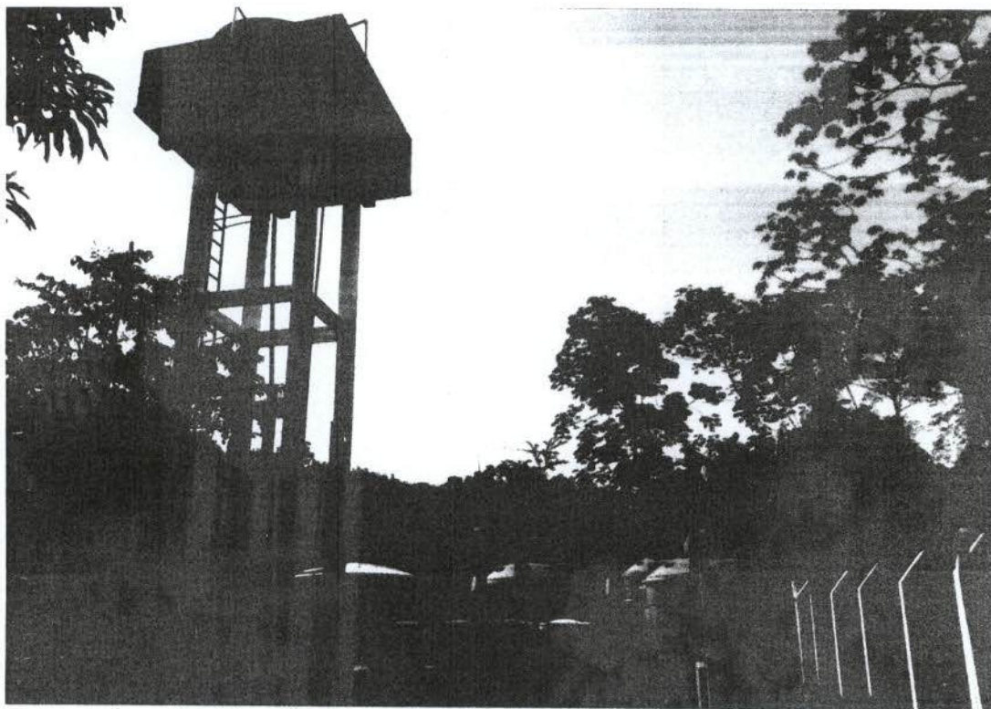
Visão geral da ETA + RE antigo
