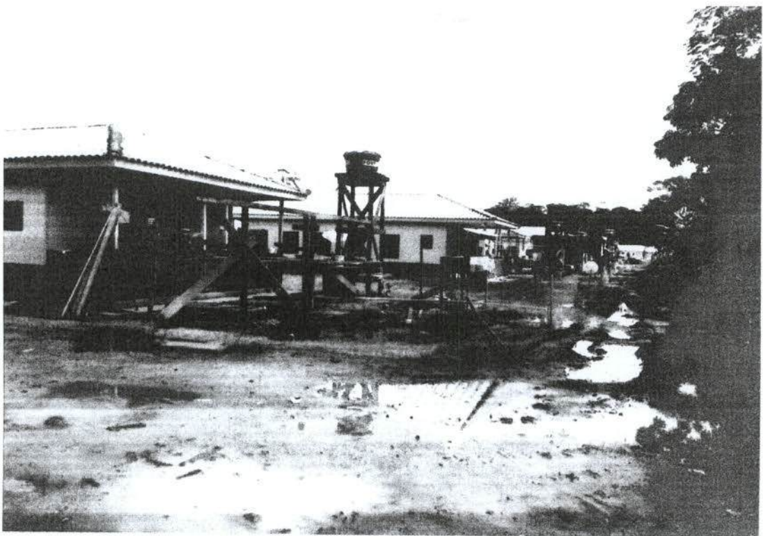
Efluentes do sistema TS + Sumidouro a céu aberto em transbordo
