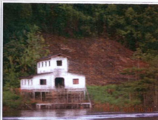
Foto 24: Supressão da vegetação e área destinada à instalação de placas solcares na Vila Santo Antônio da Cachoeira.
