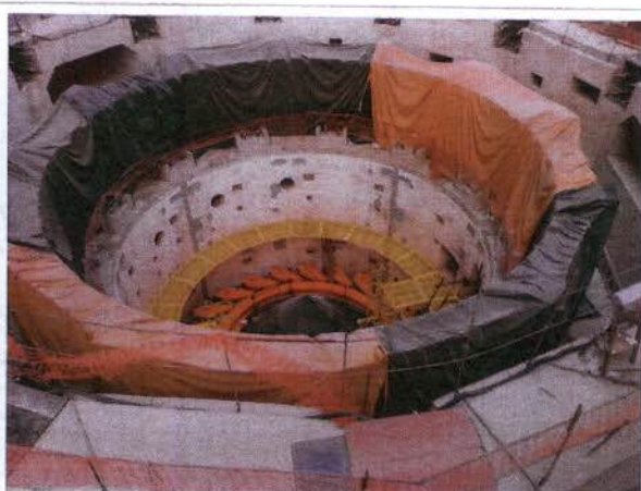
Foto 13: Máquina 1 da Casa de Força Principal, em fase avançada de instalação.
