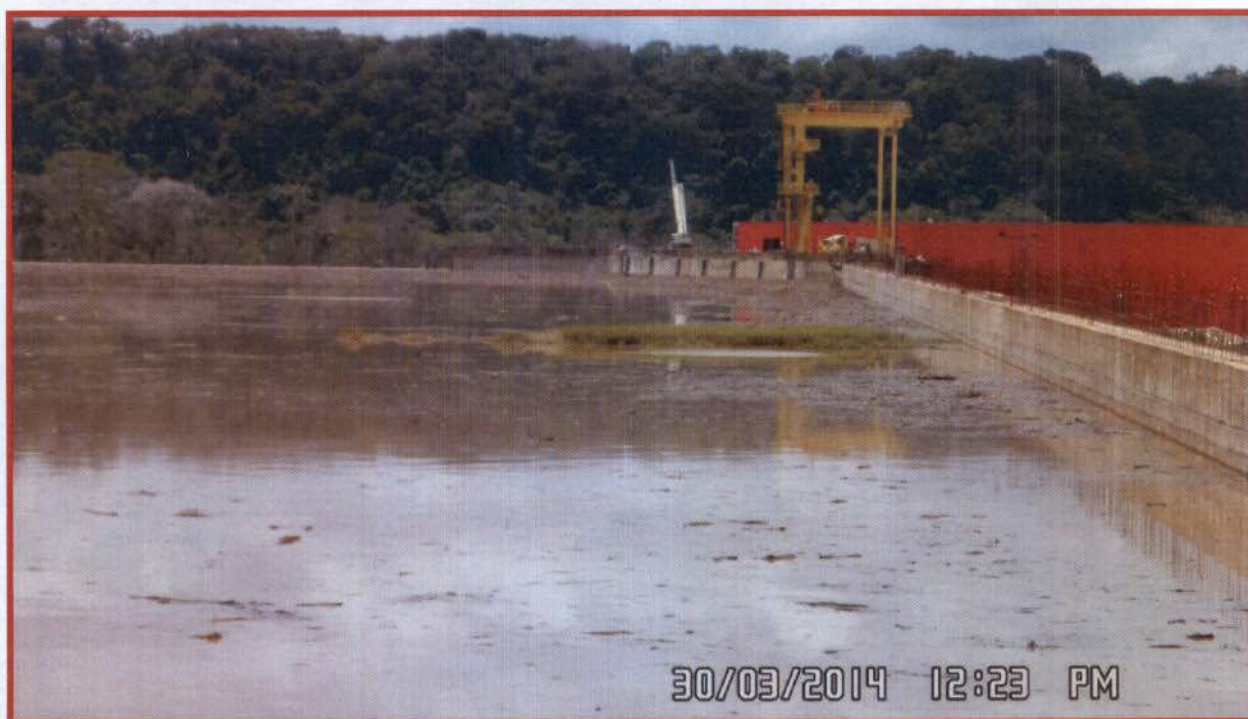
FOTO 04- VISTA A MONTANTE DA BARRAGEM CCR, NA FRENTE DA CASA DE MÁQUINAS ONDE OCORREU O ACIDENTE QUE VITIMOU OS QUATRO FUNCIONÁRIOS. NO CANTO SUPERIOR ESQUERDO OBSERVA-SE QUE O NÍVEL DE ÁGUA ESTÁ PRÓXIMO AO LIMITE SUPERIOR DO VERTEDOIRO, INDICANDO QUE POSSIVELMENTE COM A CONTINUIDADE DAS CHUVAS NA REGIÃO, O VERTEDOIRO COMEÇARÁ A SANGRAR.
