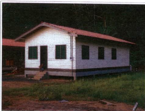
Foto 23: Nova casa da Sr a Maria da Conceição Tavarez, na Vila Santo Antônio da Cachoeira.
