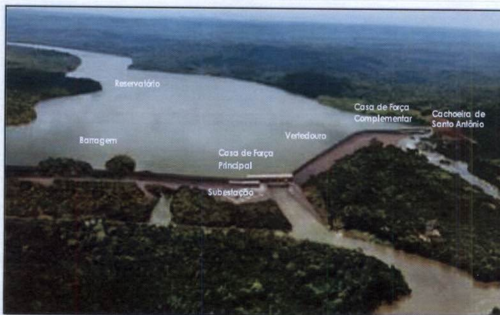
Figura 1 – Fotografia do local de implantação e imagem ilustrativa da usina
