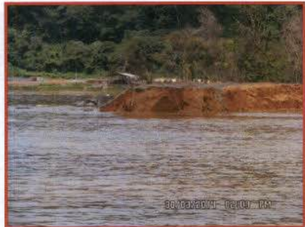
FOTO 12 E 13 - MOSTRAM DE MAIS PRÓXIMO O LOCAL DE ROMPIMENTO DA ENSECADEIRA
