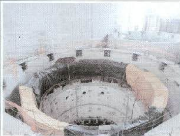
Foto 02: Turbina em fase de montagem na casa de força
