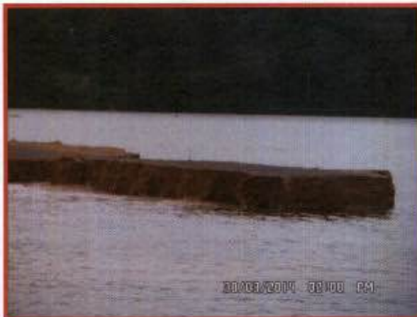
FOTO 12 E 13 - MOSTRAM DE MAIS PRÓXIMO O LOCAL DE ROMPIMENTO DA ENSECADEIRA
