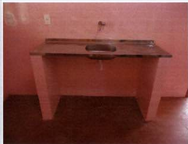
Foto 4: Detalhe da pia da cozinha em alvenaria.
