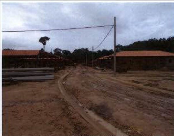
Foto 5: estágio das obras da "Ala Norte" da Vila Iratapuru (16 casas).
