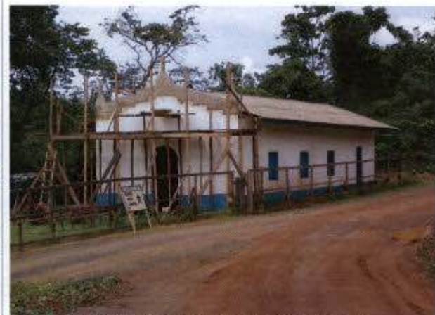
Foto 10: Reforma da Igreja na Vila Santo Antônio.
