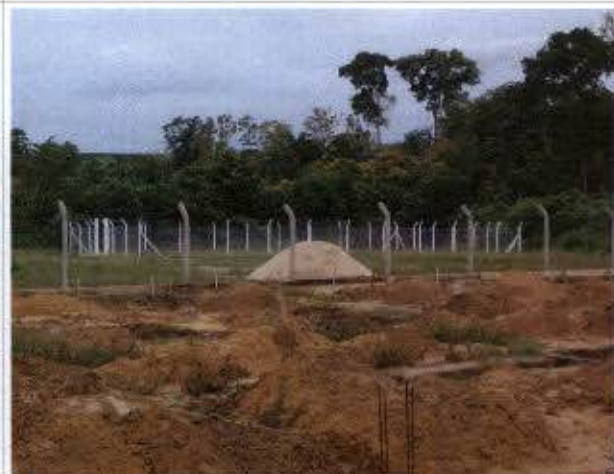
Foto 6: Área de instalação dos painéis solares e ao fundo cemitério.
