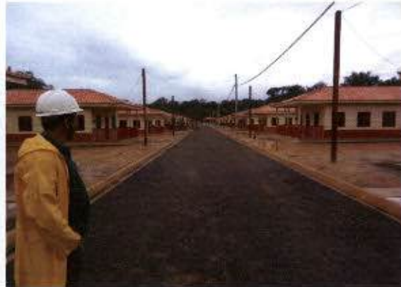
Foto 2: Construção das novas casas da Vila Iratapuru.
