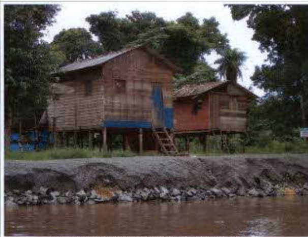
Foto 9: Detalhe de casas e erosão na Vila São José.
