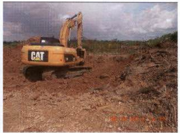
Foto 02: Galhada em vala sendo compactada após ser enterrada.
