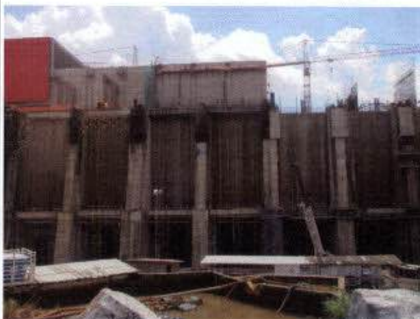
Foto 04: Detalhe da Casa de Força.
