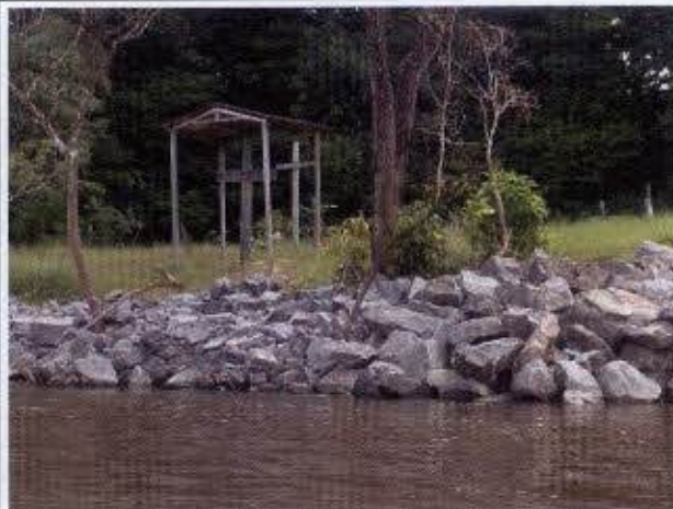
Foto 10: Contenção do processo erosivo no cemitério local.
