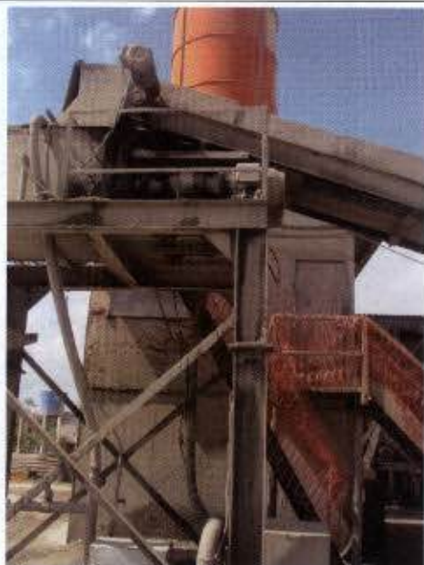
Foto 03: Detalhe da Casa de Força.
