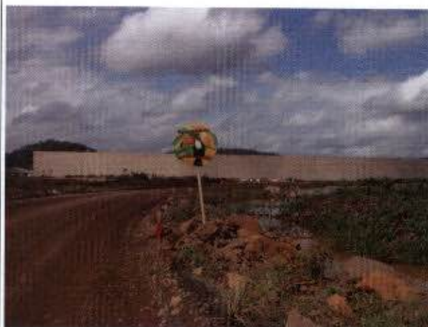
Foto 02: Placas de sinalização da fauna dentro do canteiro de obras.
