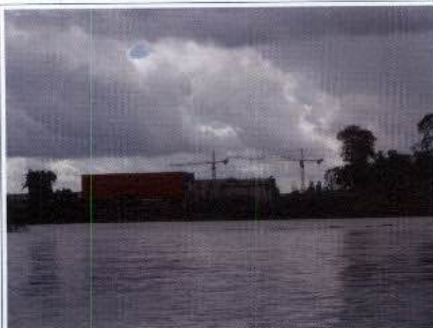
Foto 05: Vista da Casa de Força a partir do Rio Jari.
