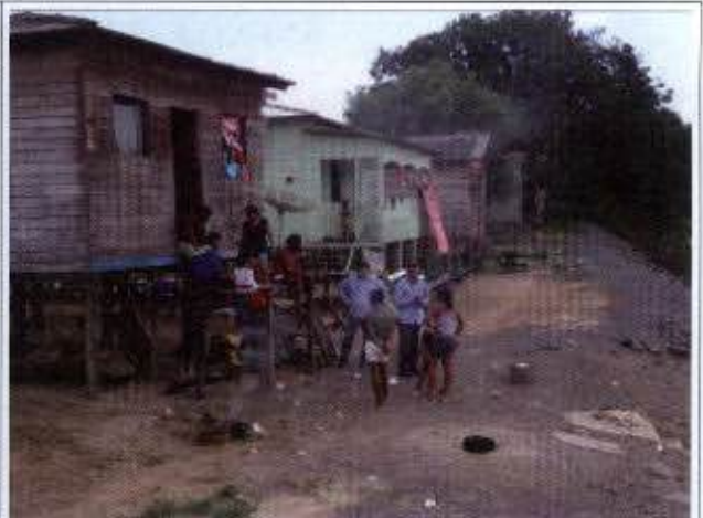
Foto 08: Vista parcial da Vila São José com detalhe dos serviços de contenção de erosão na margem do rio jari.
