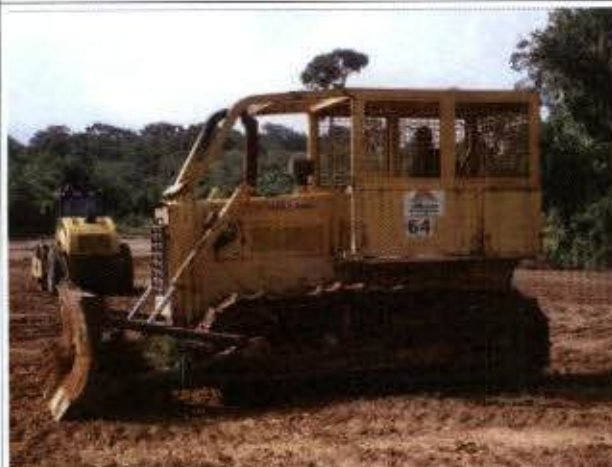
Foto 03: Serviço de terraplanagem na Vila Iratapuru.
