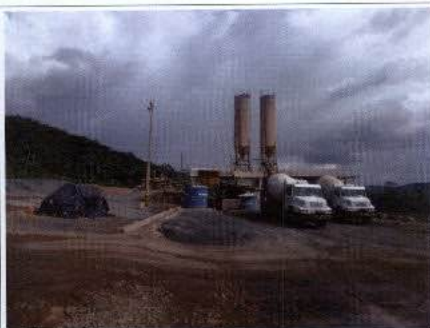
Foto 06: Não conformidades de canaletas e concreto espalhado sanadas.
