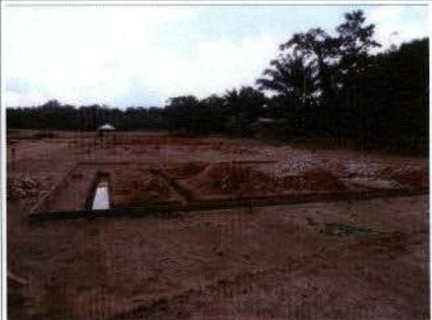
Foto 02: Detalhe da marcação do gabarito das futuras casas na Vila Iratapuru.
