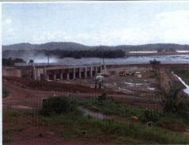
Foto 08: Vista da Casa de Força Secundária e do canal de espalhamento.
