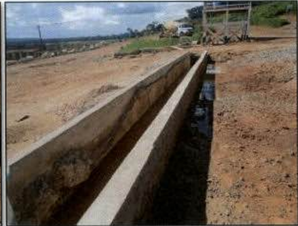
Reconstrução das canaletas
