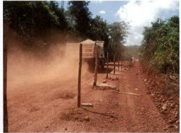
Foto 04 – Acesso em construção
