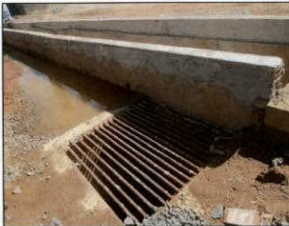
Retirada dos restos de concreto
