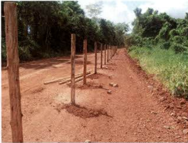
Foto 03 – Acesso em construção
