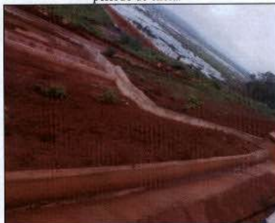
Foto 03: Aplicação de Hidrossemeadura em talude do canteiro secundário (Programa de Recuperação de Áreas Degradadas – PRAD).
