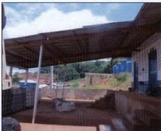
Foto 05: Central de segregação de resíduos do canteiro secundário.
