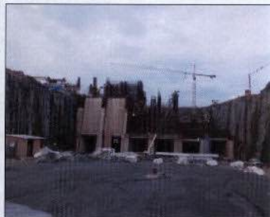
Foto 20: Obras da casa de força principal (margem direita).
