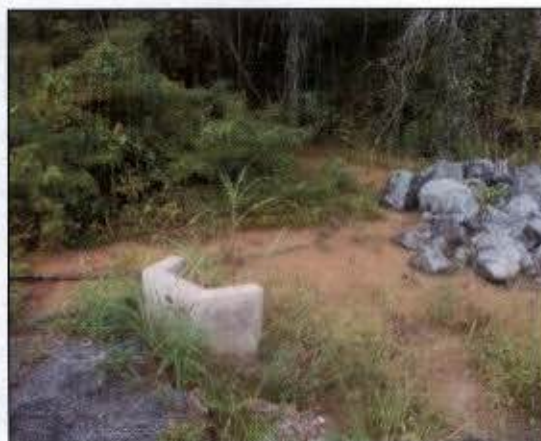
Foto 27: Área onde o efluente gerado na rampa de lavagem (canteiro principal) era lançado anteriormente: ausência de coloração indicativa de óleo.
