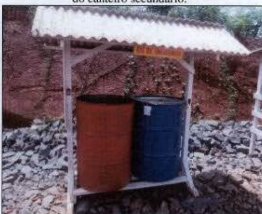
Foto 10: Kit de emergência da "área de manutenção remota" de veículos e maquinários (canteiro secundário).
