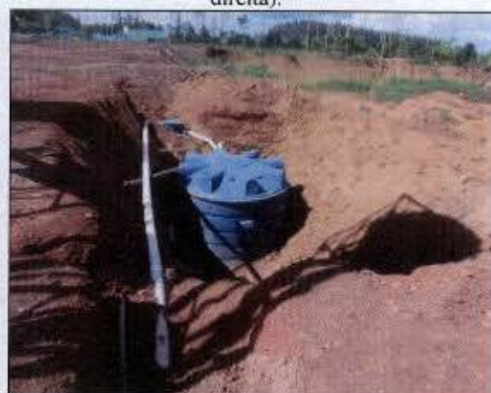
Foto 22: Implantação de fossa séptica do alojamento técnico-operacional (canteiro principal).
