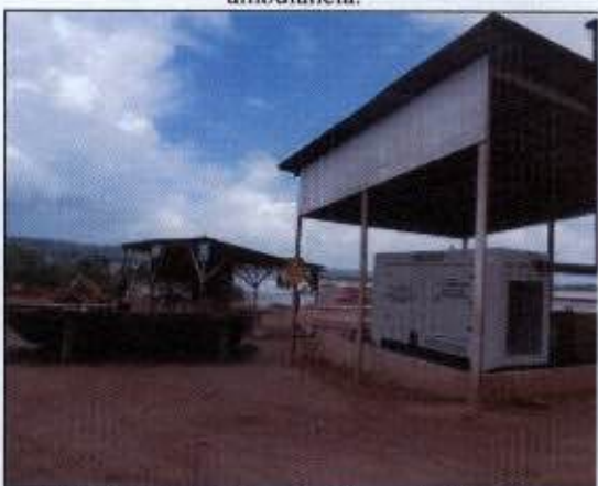
Foto 09: Bacia de contenção e cobertura de maquinário a base de diesel.
