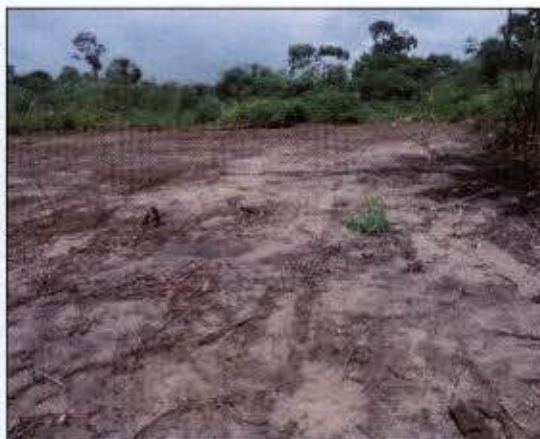
Foto 50: Supressão Vegetal onde será a nova Vila de Iratapuru
