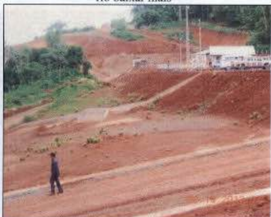
Foto 34 - Taludes com sementes germinando (PRAD)
