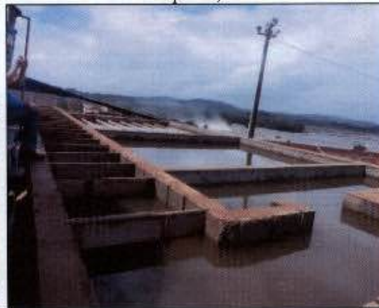
Foto 04: Sistema de decantação e filtragem da água bruta trazida do canteiro principal (atividades industriais).
