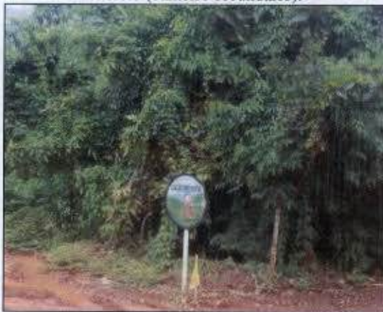
Foto 19: Sinalização no canteiro de obras secundário.
