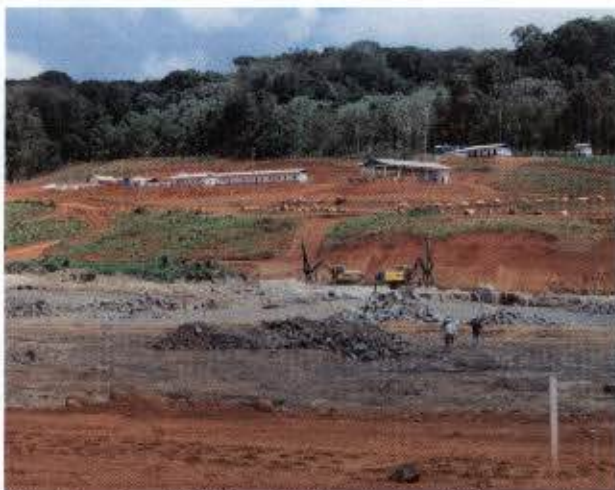
Foto 25 – Local da Casa de Força secundária – margem esquerda
