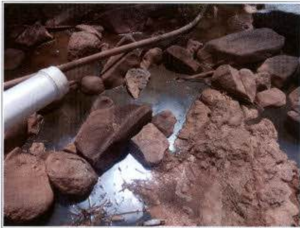
Foto 05 – Mistura de água e óleo, lançada no leito ensecado do rio (após a passagem pela caixa separadora de água/óleo; agosto/2012)
