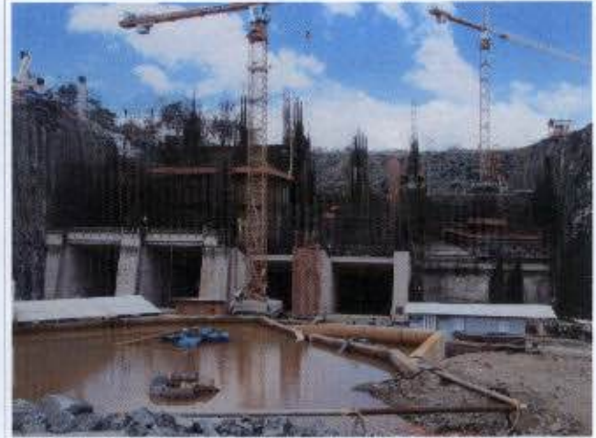
Foto 34 – Casa de Força principal, margem esquerda
