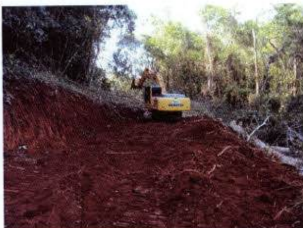
Figura 03. Supressão sentido jusante a montante.
