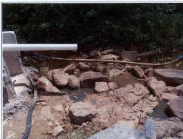
Foto 01 – Visão geral da área de lançamento da rampa de lavagem (agosto/2012)
