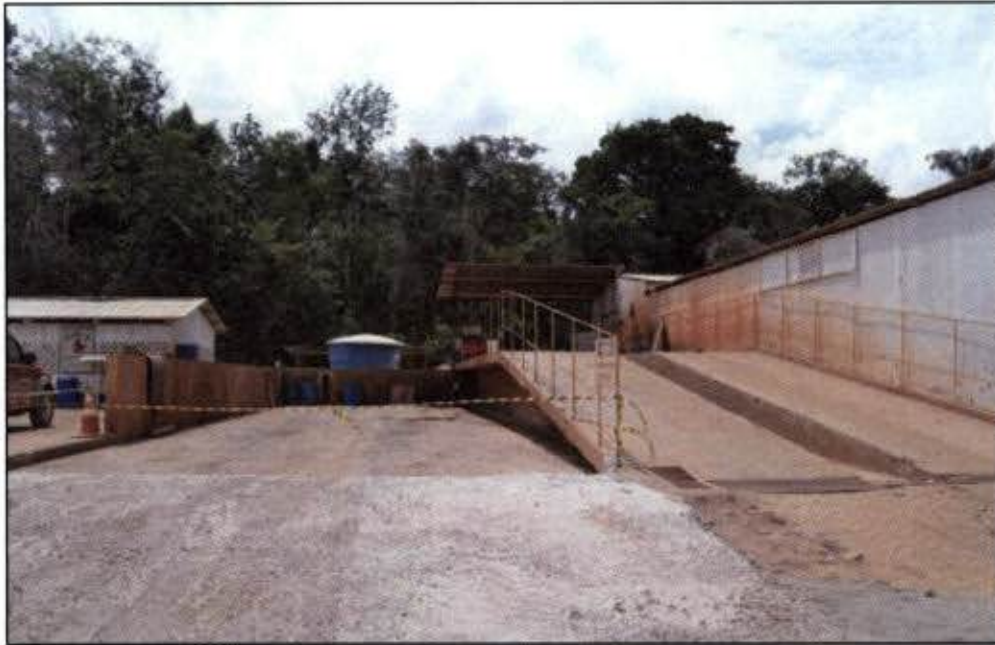
Imagem 02 – Vista frontal do Sistema de lavagem de veículos pesados e troca de óleo
