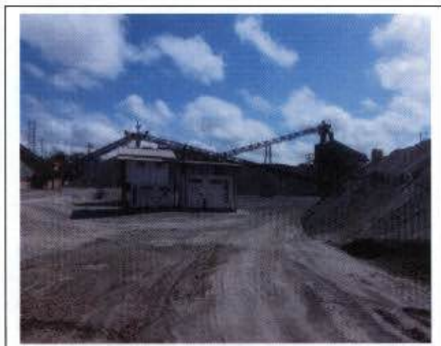
Foto 03: Central de Britagem (canteiro principal).
