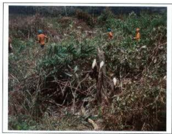
Foto 46: Atividade "roço" na área da Ensecadeira "B": eliminação de cipós e da vegetação de sub-bosque.
