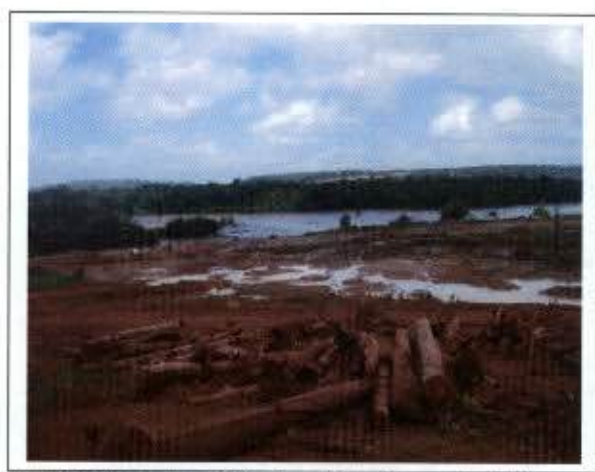
Foto 47: Estoque provisório da matéria prima suprimida (canteiro secundário, margem esquerda).
