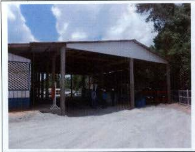
Foto 17: Readequações na Central de Triagem de Resíduos (canteiro principal).
