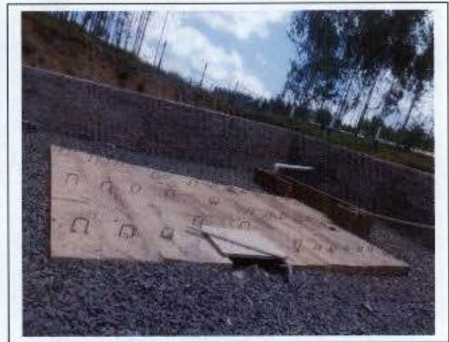
Foto 20: Local de leitura do efluente na estrada da ETE (canteiro principal).
