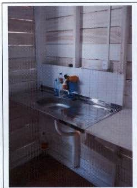
Foto 29: Sala de preparo de alimentos - Centro de Triagem de Fauna.
