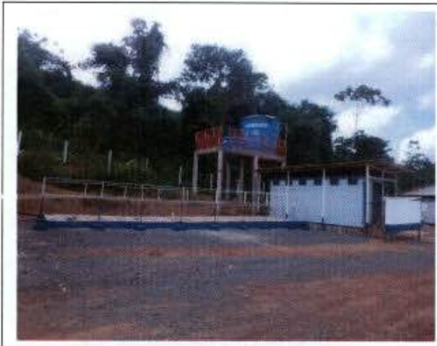
Foto 25: Sistema de fossa séptica, filtro e sumidouro já instalado para efluentes sanitários gerados no Canteiro Auxiliar 01 (canteiro secundário).
