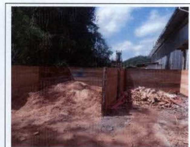
Foto 08: Armazenamento temporário do material a ser utilizado na Central de Carpintaria.
