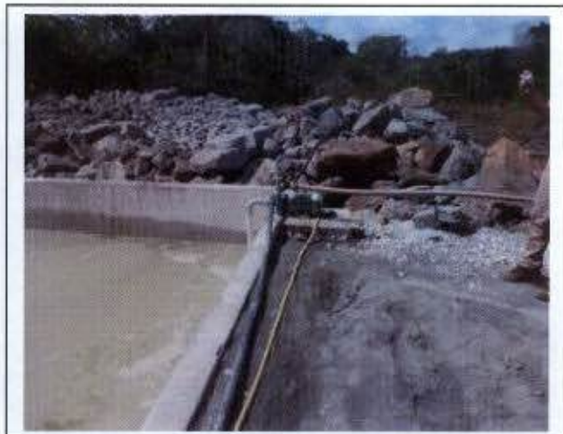
Foto 06: Bombeamento para recirculação da água de lavagem das betoneiras.
