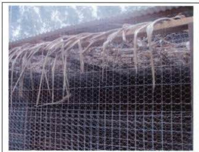
Foto 38: Palha acima dos recintos para redução de calor - Centro de Triagem de Fauna.
