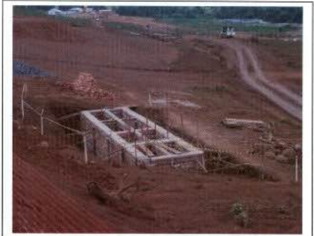
Foto 26: Sistema de fossa séptica, filtro e sumidouro em implantação no Canteiro Auxiliar 02 para efluentes sanitários (canteiro secundário).
