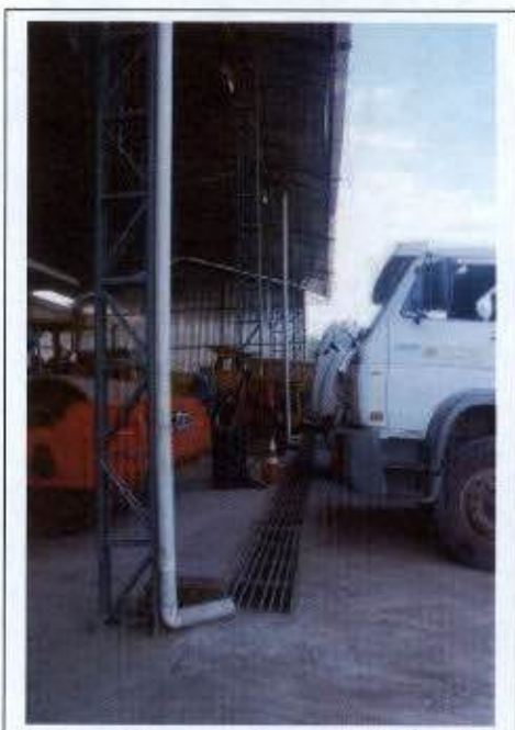
Foto 09: Canaletas para o efluente da Oficina Mecânica.
