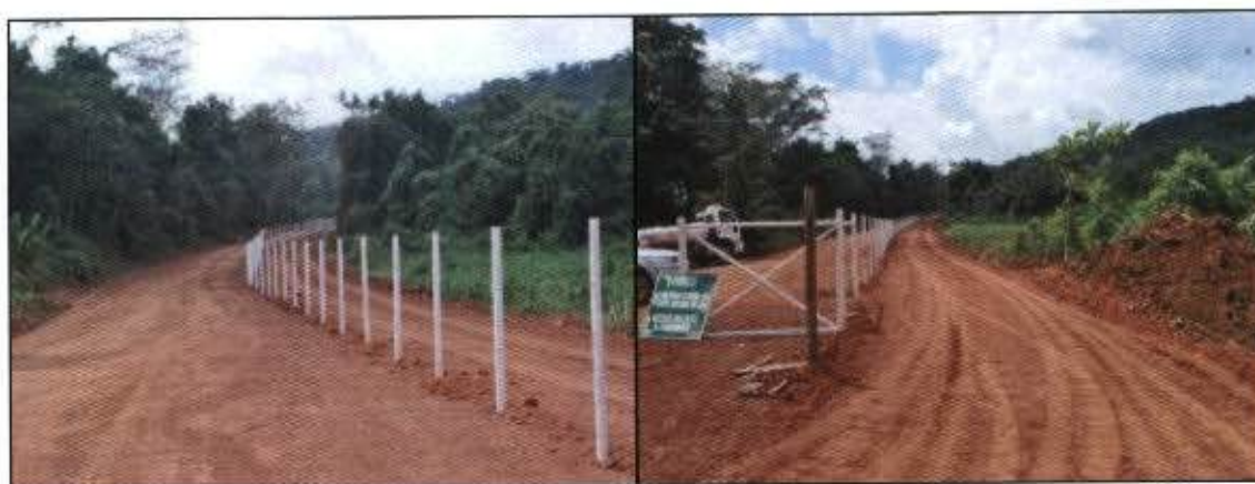
Figuras 06 e 07 – Recuperação do acesso dos moradores da Vila Santo Antônio, com implantação de cercas e serviços de terraplanagem.
