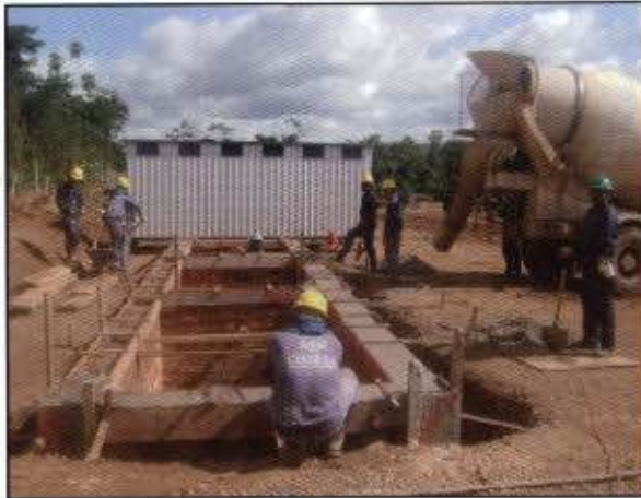
Figura 03 – Construção da fossa séptica com sistema filtro sumidouro, ao lado, banheiro contêiner para atender os funcionários da margem esquerda no canteiro auxiliar 01.
