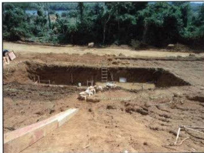
Figura 06 – Construção da fossa filtro sumidouro para atender ao Canteiro auxiliar 02
