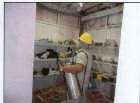
Borrifação no Laboratório de Concreto
