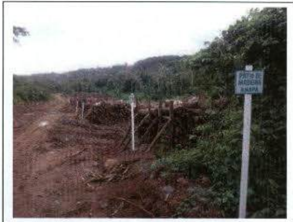
Foto 39 – Via de Acesso principal à vila de Santo Antônio que será inutilizada com a construção do Canteiro de Obras Secundário (margem esquerda do rio Jari)
