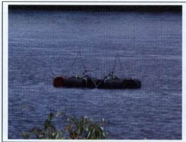
Foto 11 – Bombas de captação de água no rio Jari
