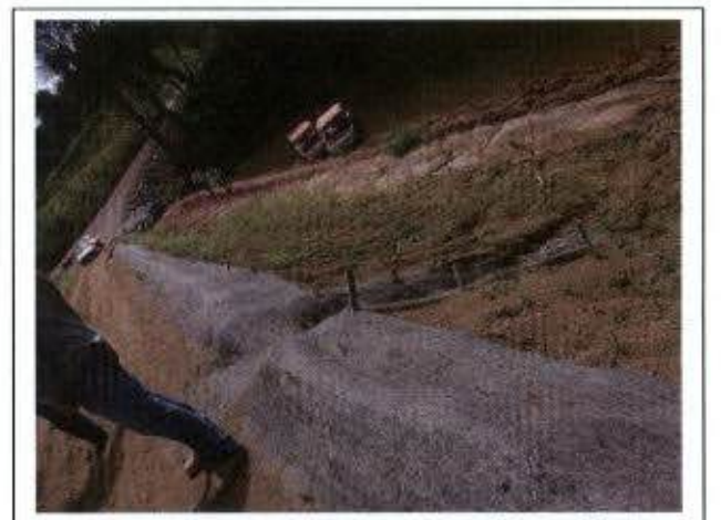
Foto 32 - Obras de contenção de talude próximas à Ensecadeira C1
