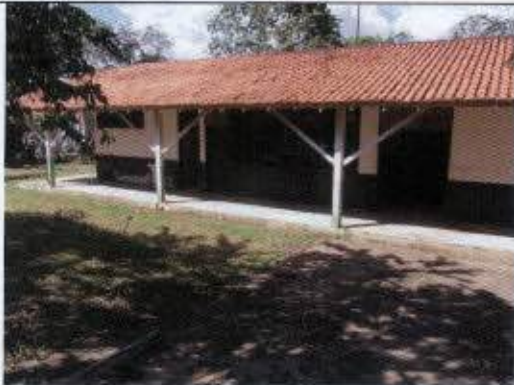
Foto 1A: Vista geral da área externa do Centro de Apoio da Vila Iratapuru.
