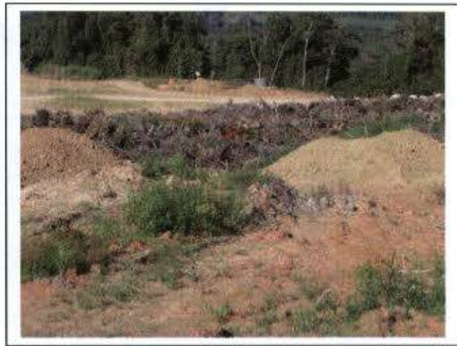
Foto 16 – Galhadas das ASV N° 560/2011 e 566/2011, disposta na Área de jazida do canteiro administrativo (Cota 95m)
