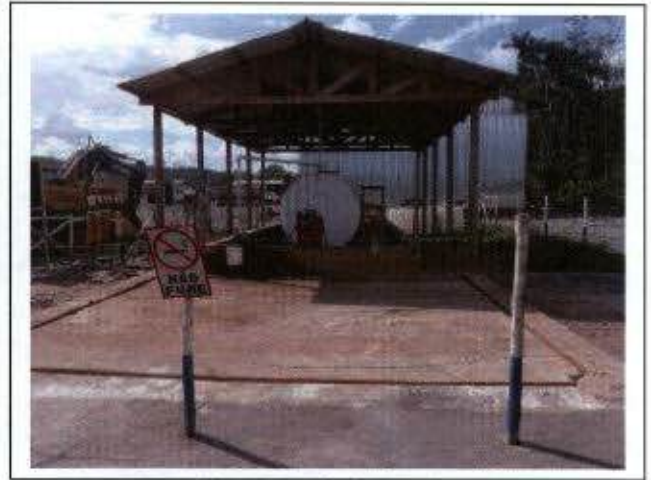
Foto 28 - Posto de abastecimento
