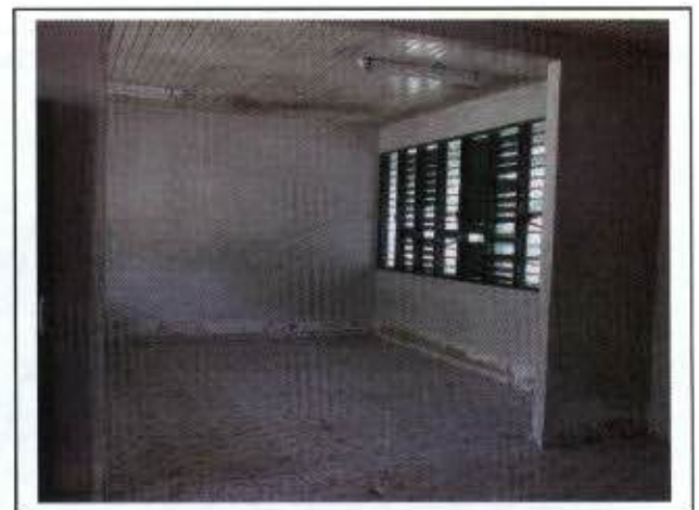
Foto 52 – Estrutura na Vila de Iratapuru que servirá de Centro de Apoio para o resgate de fauna
