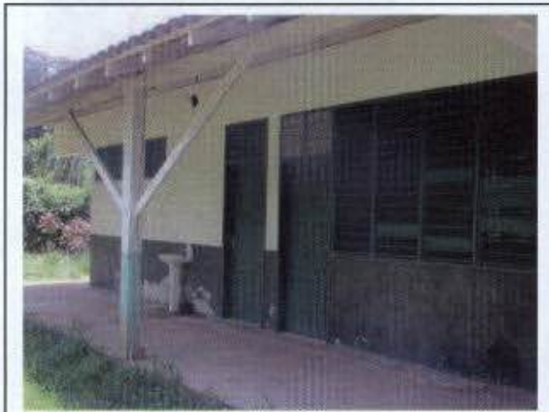
Foto 53 – Visão externa da estrutura Estrutura na Vila de Iratapuru que servirá de Centro de Apoio para o resgate de fauna
