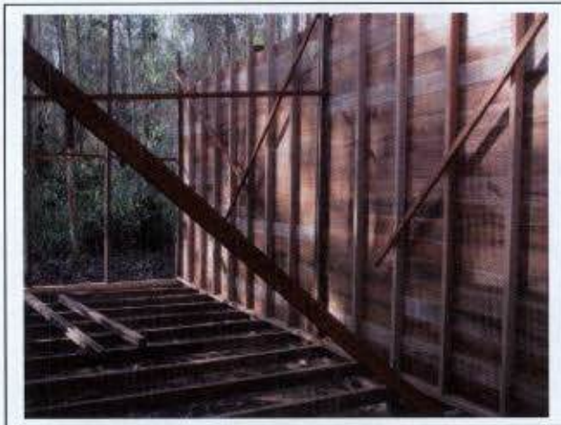
Foto 43 – Construção da terceira estrutura no Centro de Triagem de Fauna
