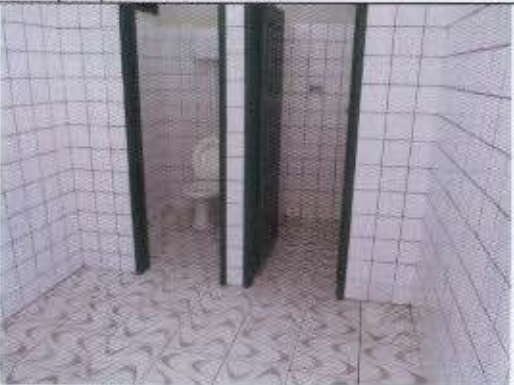
Foto 1E: Vista da área interna do banheiro do A.C.
