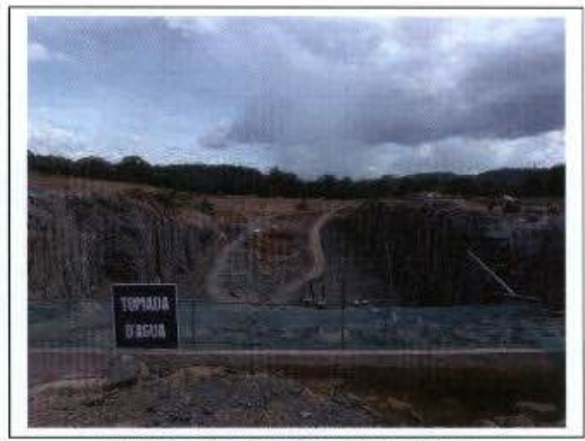
Foto 30 - Obras do Circuito Hidráulico
