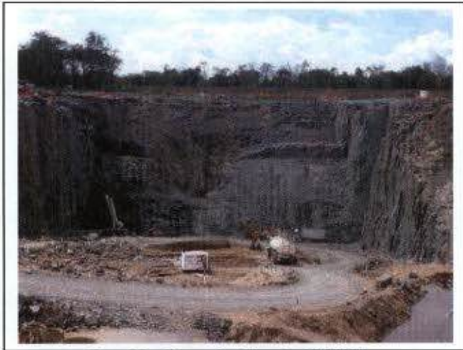
Foto 29 - Obras do Circuito Hidráulico
