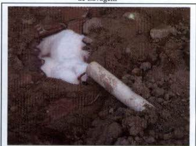
Foto 24 – Efluente lançado diretamente no rio Jari após a separação do óleo na Caixa Separadora de Água/Óleo: presença de espuma, indicativa da presença de detergente industrial
