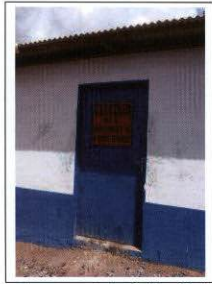
Foto 4 – Armazenamento dos Resíduos Perigosos na Centra de Resíduos
