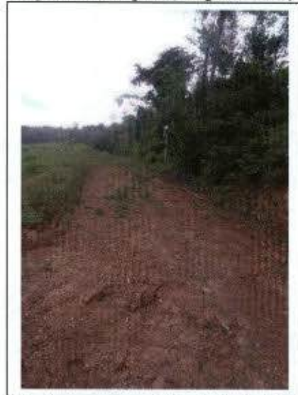
Foto 40 – Via de acesso secundário à vila de Santo Antônio que será melhorada para uso da população da vila
