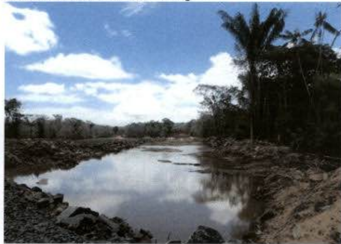
Foto 08: Local do Eixo da barragem
