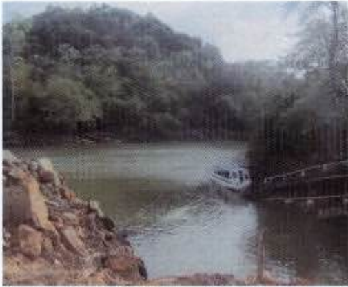
Foto 3 – Porto “Cesbe” no canteiro industrial
