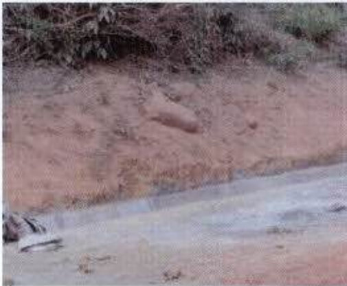
Foto 5 – Obras de drenagem de um acesso
