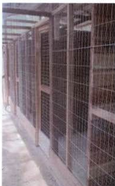
Foto 25 – Recintos do Centro de Triagem no canteiro de obras
