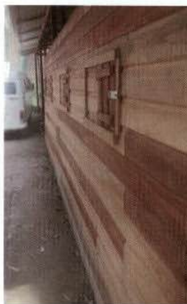
Foto 26 - -- Recintos do Centro de Triagem no canteiro de obras
