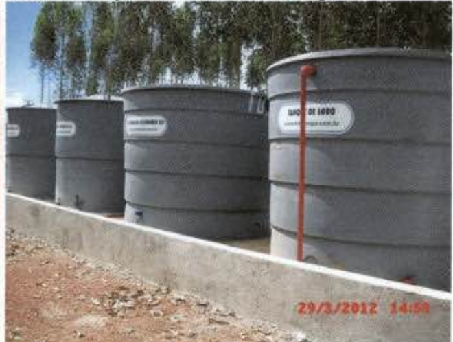
Foto 04: Estação de Tratamento de Esgoto
