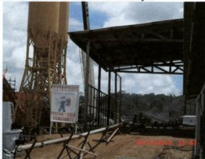
Foto 09: Canteiro industrial em instalação
