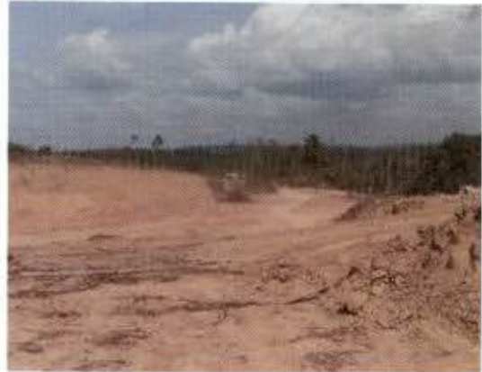
Foto 12 - Área de empréstimo com a retirada de camada de solo orgânico
