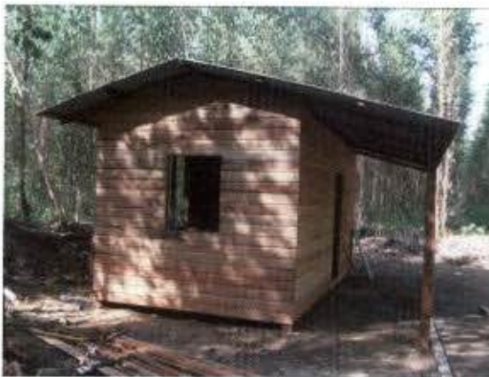
FOTO 03 - Construção do Centro de Triagem na margem direita do rio Jari para dar apoio às atividades de resgate de fauna na área do canteiro de obras. Núcleo de Apoio Veterinário – NAV.
