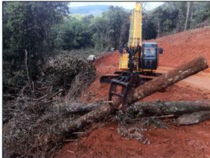
Foto 4-3 – Escavadeira hidráulica removendo tronco.
