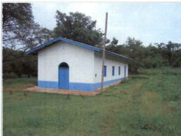
Foto 12: Igreja de Santo Antônio, localizada na Vila de Santo Antônio, após a reforma.
