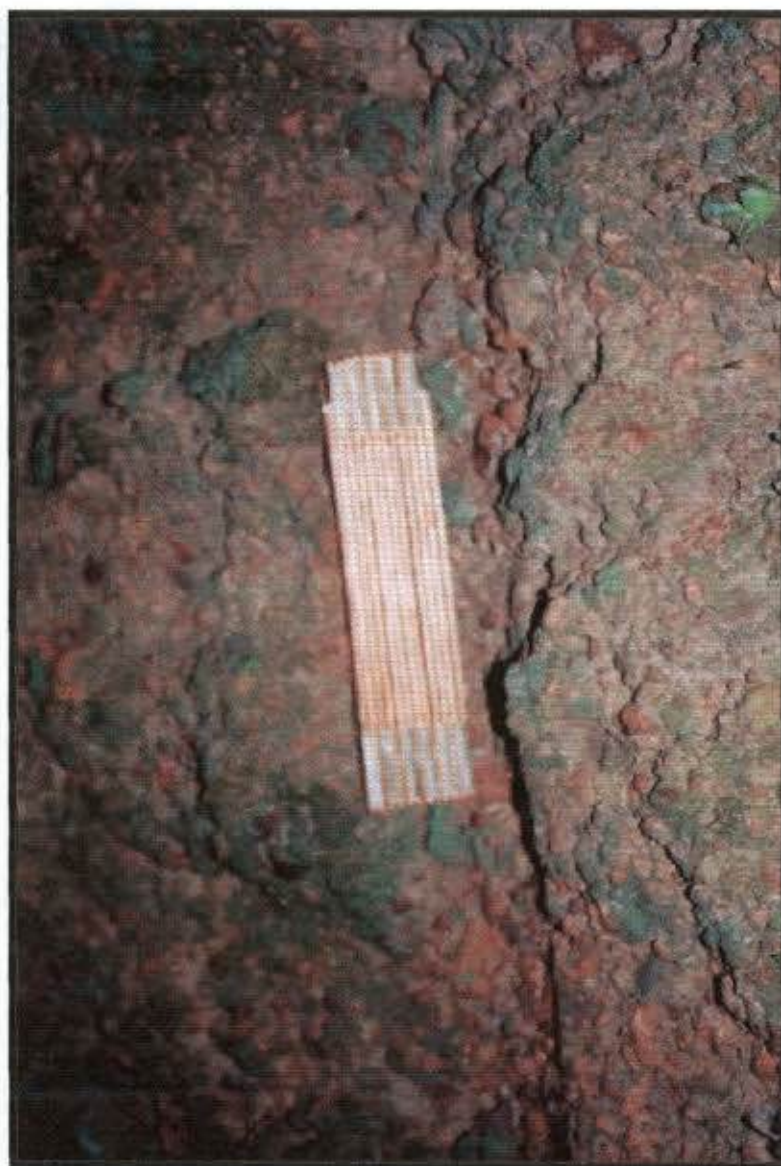
FOTO 24: Zoom na composição da parede da edificação
