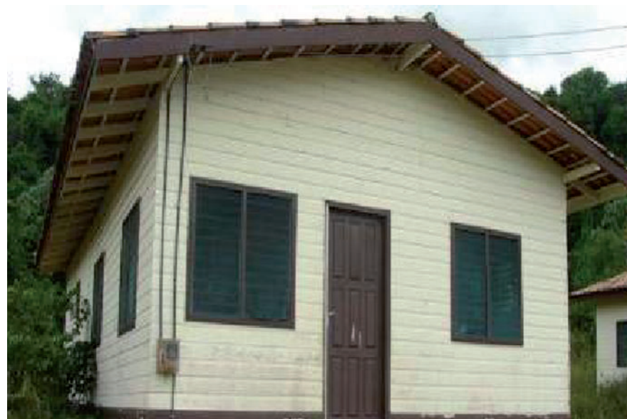
Casa construída em 2001, pela JESA, na Vila de Santo Antônio
