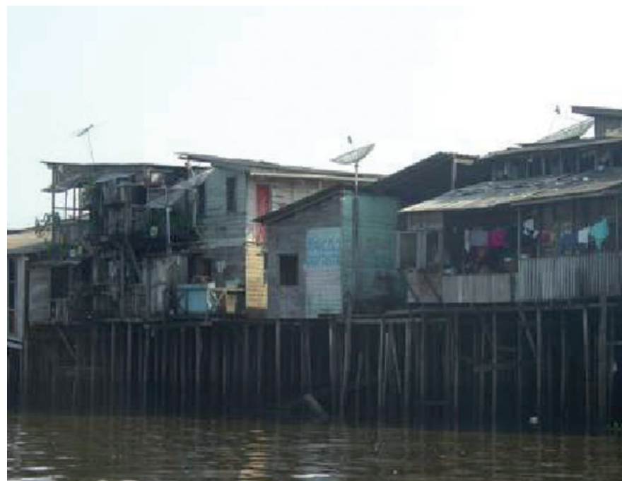
Casas construídas em palafitas no bairro das Malvinas em Laranjal do Jari
