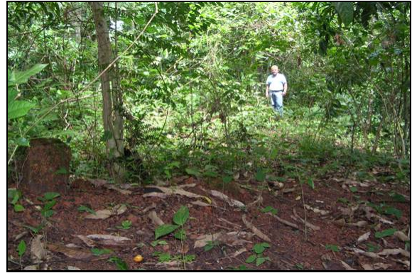
Foto 10 - Vista da parede que já foi destruída. A queda de várias árvores no local já comprometeu grande parte da antiga construção
