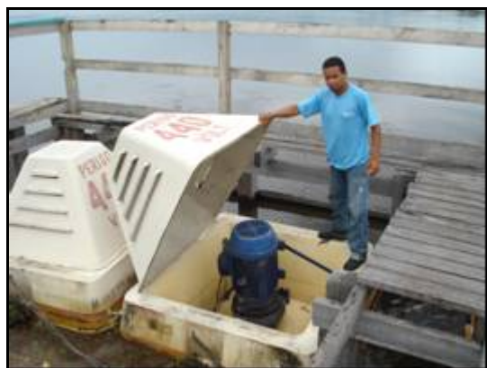
Figura 8.4-26 - Estruturas para captação de Água - Laranjal do Jari
