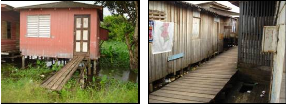
Figura 8.4-28 - Esgoto a Céu Aberto- Laranjal do Jari
