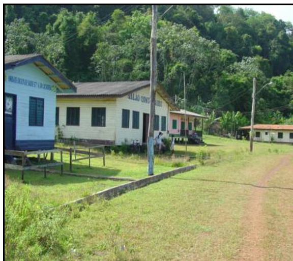
Figura 8.4-3 - Vista parcial da Vila de Santo Antônio reassentada
