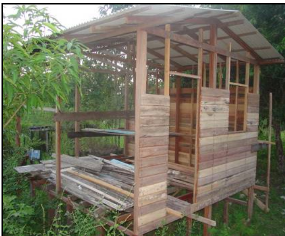
Figura 8.4-137 - Casa sendo construída no Bairro Malvinas
