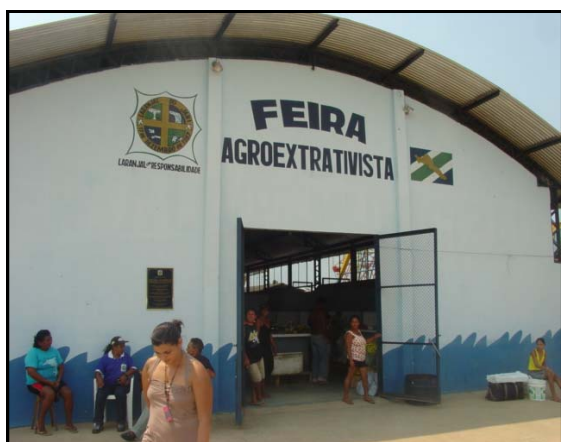
Figura 8.4-49 - Vista externa do galpão destinado a receber o mercado do peixe e feira do agricultor
