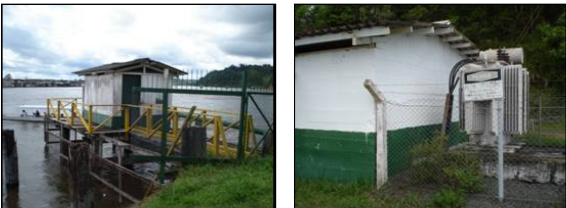
Figura 8.4-29 - Estruturas de captação de água nas margens do rio Jari 22 m 328488/9905204
