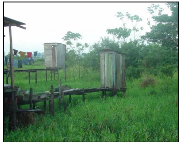
Figura 8.4-82 - Banheiros construídos fora da casa, no bairro Malvinas
