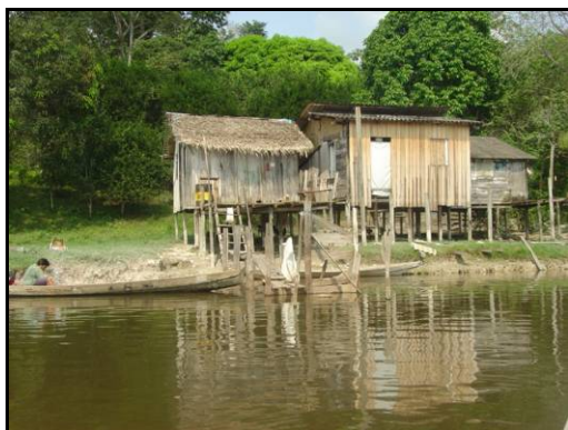
Figura 8.4-149 - Casas na palafita na região de Porto Sabão, a montante a cachoeira.
