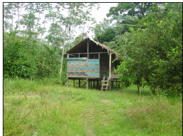
Figura 8.4-78 - Habitação na localidade de Pinuquara
