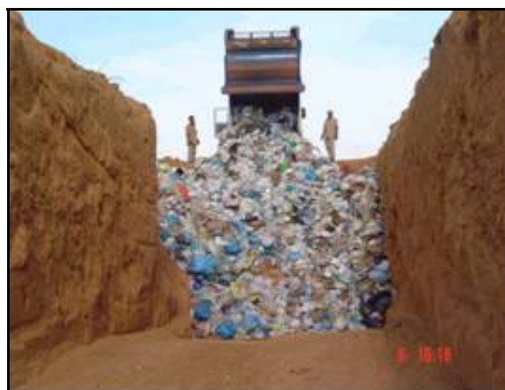
Figura 8.4-24 - Lixo disposto nas valas
