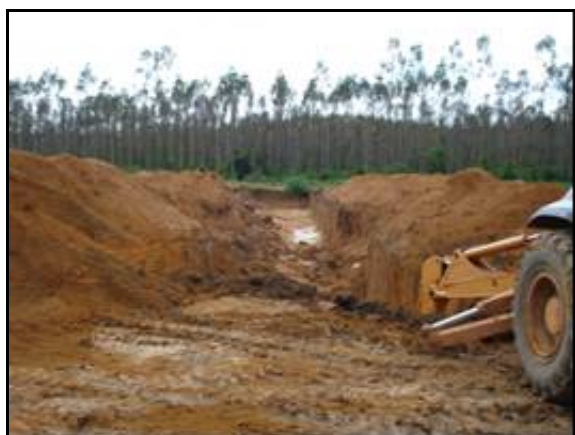
Figura 8.4-23 - Abertura de valas no aterro. Coordenadas 22 m 333483/9903362
