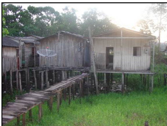
Figura 8.4-135 - Casas localizadas no Bairro das Malvinas
