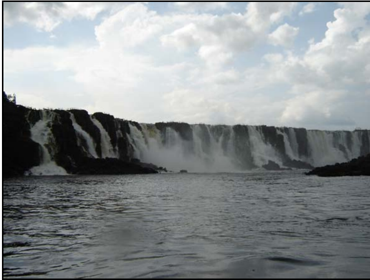
Foto 3 - Vazão 375 m 3 /s.
