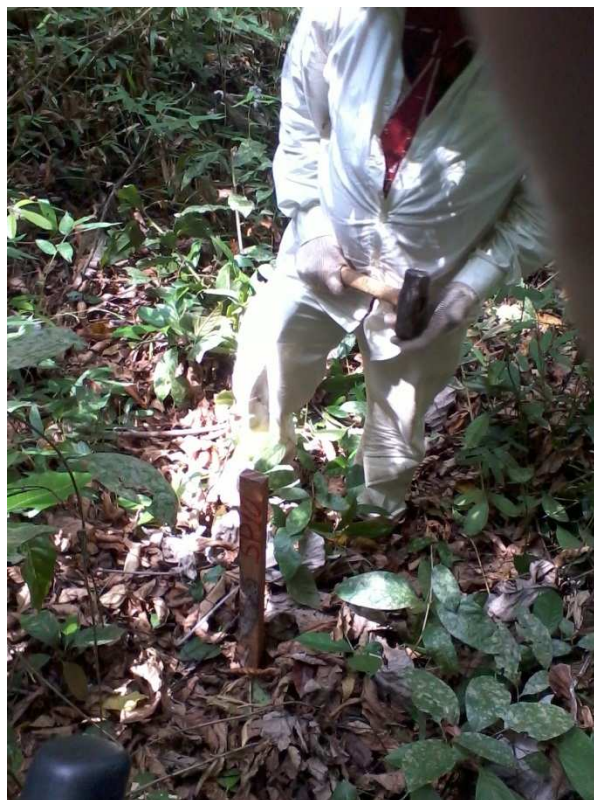
Foto A2.10 – Foto do local previsto para a perfuração do piezômetro SP10.
