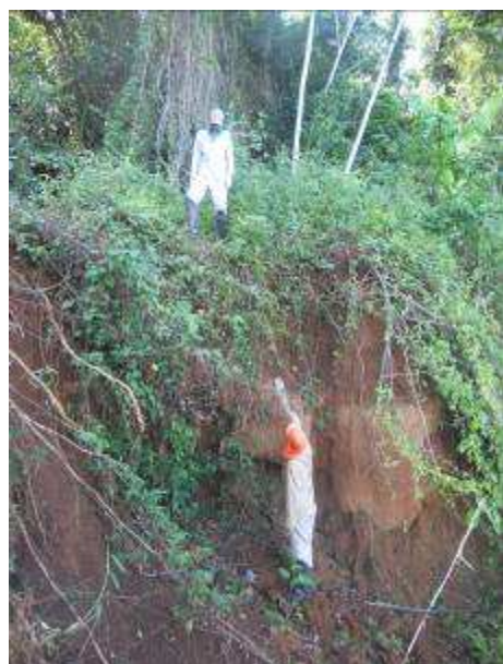
Foto 12. Vista de barranco em processo de solapamento nas margens do Rio Jarí.
