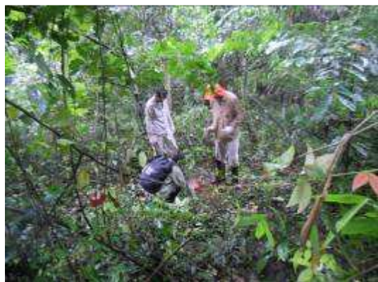
Foto 19. Sondagem realizada na área do acesso provisório.
