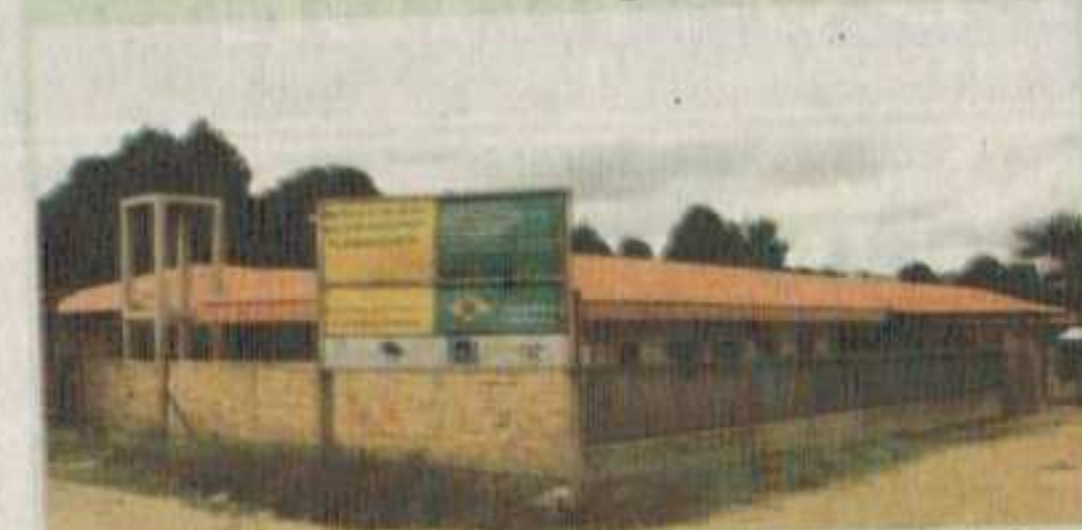
Novo prédio da Escola Nazaré Mineiro
